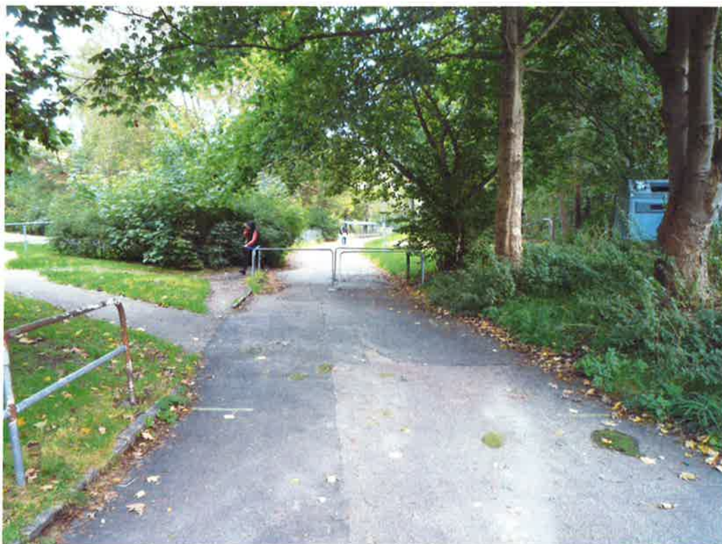
Befintlig gångväg mellan Riksdalergatan och Guldmyntsgatan.
