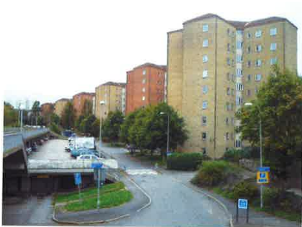
Stjärnhusen utefter Bankogatan. Huset längst bort är sju våningar och det närmaste huset är nio våningar.
