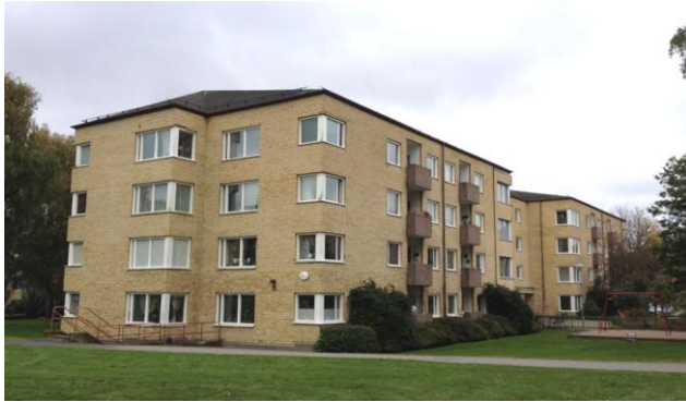
En av de byggnader som kommer att byggas på
