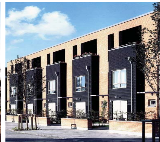
Olika material kan kombineras. Inspirationsbild: Sannegårdshamnen, Göteborg
