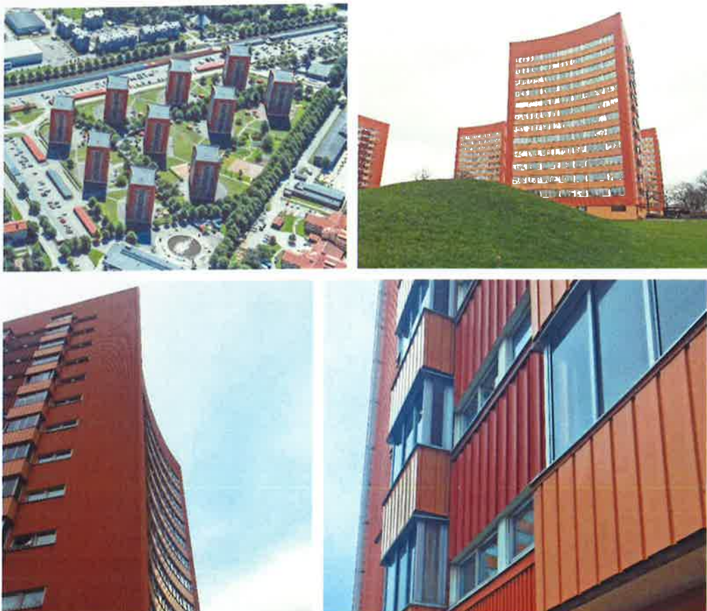
Flygbild över planområdet, foto på de konkava fasaderna, en gavelfasad sett från marknivå samt närbild på balkonger, här inglasade med profiler.
