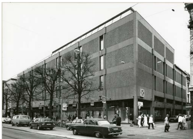
Foto från 1970-talet, fasad mot Östra Hamngatan och Kyrkogatan. Byggnaden gavs fyra våningar mot det breda huvudstråket medan höjdskalet mot de smalare kvartersgatorna trappades ner till tre våningar.
