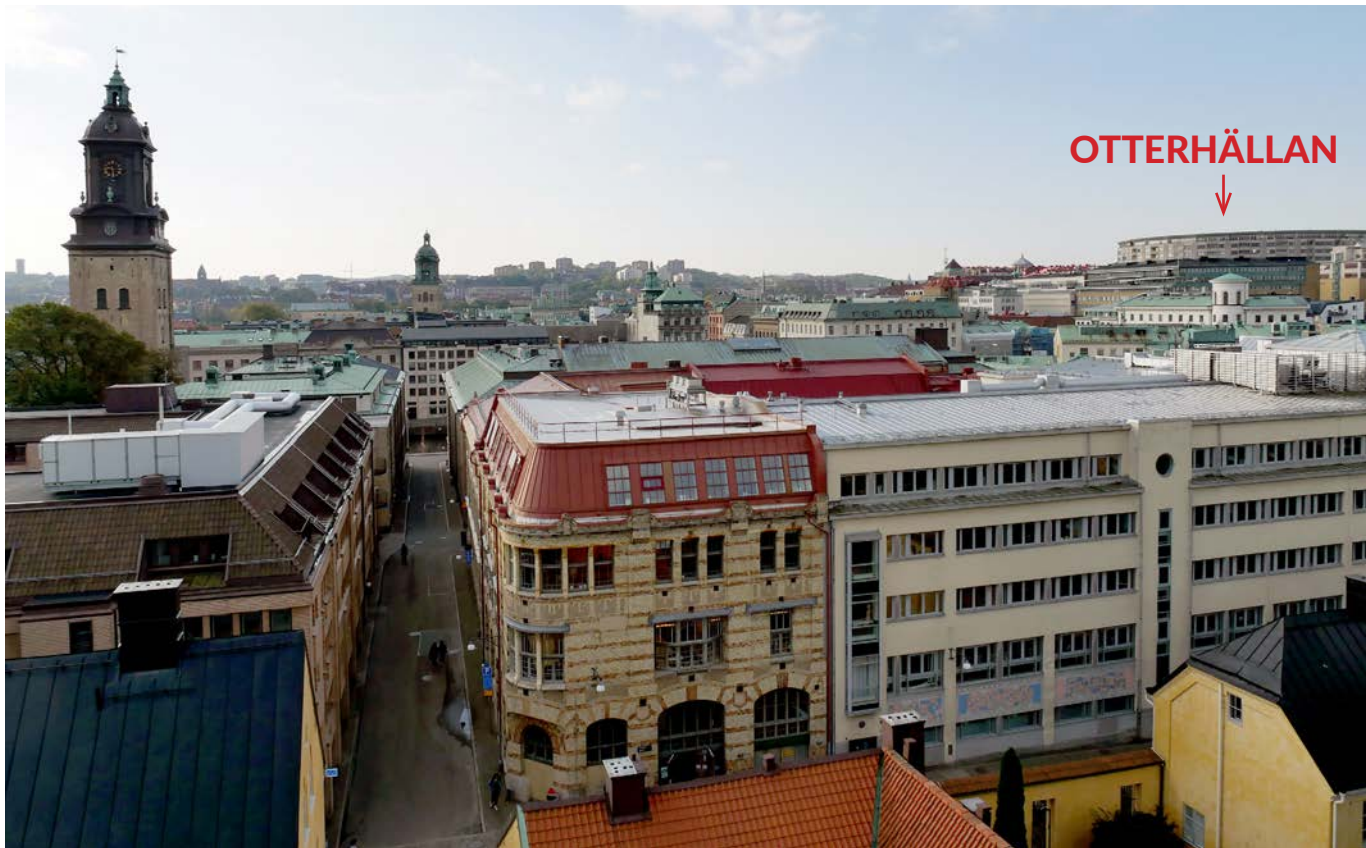
Vy över Göteborg från Kronhusets tak. En tydlig nedtrappning av bebyggelsen sker från Otterhällans höjd.
