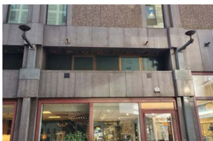
I bottenvåningen finns flera ursprungliga armaturer. Inschaket i fasaden ovan skyltfönstren fungerade ursprungligen som ljusinsläpp för arkadgången.
