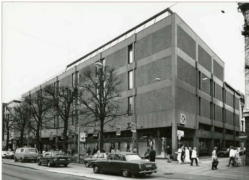
NK's huvudbyggnad mot Östra Hamngatan (hus E), uppfördes 1971 efter ritningar av Contekton. Skyltfönstren låg ursprungligen indragna i arkadgångar. Byggnaden gavs ett exteriört uttryck som är typiskt för tidens varuhus med ett slutet och inåtvänt formspråk. Konstruktionen användes som ett arkitektoniskt uttrycksmedel i fasaderna. Bärande delar kläddes med terrazzosten, där stenmaterialet utgjordes av labradorsten, medan täta fasadpartier kläddes med fasadskivor av betong med frilagd ballast. Källa: GSM.
