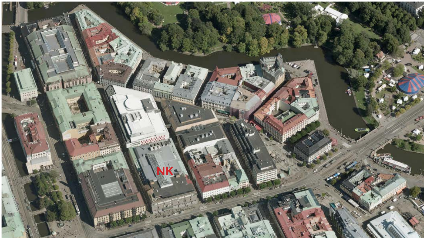
Den femtedel av stadsområdet som kv Värnamo ligger i är än idag avläsbar som en gräns för 1600-talsstaden i sydöst. Larmgatans form och kvarterens avfasade former mot öst återspeglar den anpassning som gjordes efter befästningarnas form.
