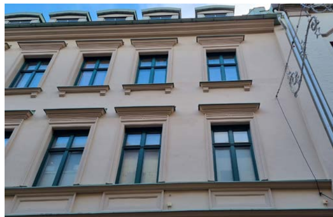
Fönster placerade djupt in i fasaden med breda mittposter ger ett något klumpigt uttryck.
