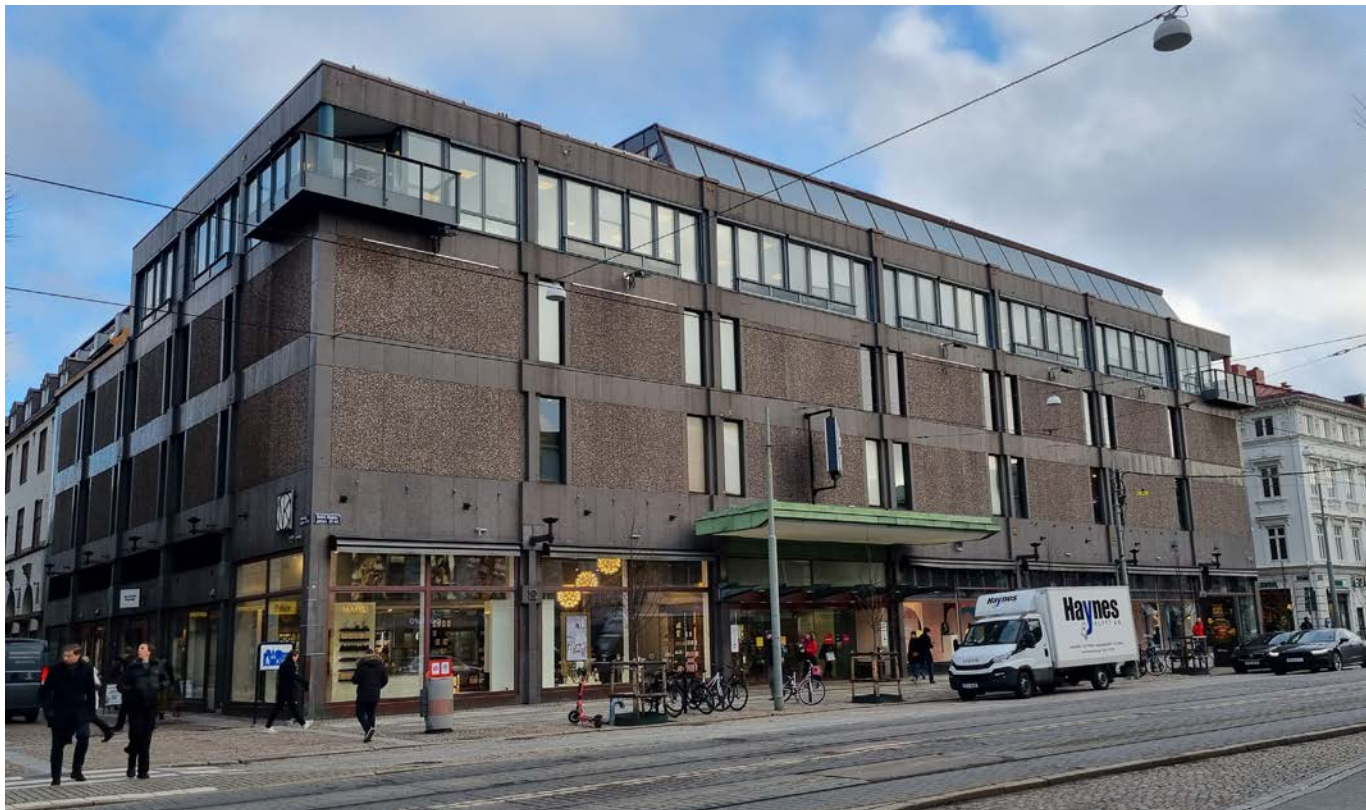
Hus E, huvudfasad mot Östra Hamngatan. Bottenvåningen upptas av skyltfönster och huvudentrén markeras av ett sentida skärmtak. Fasad i våning fyra glasades upp på 1990-talet men i våning 2-3 är den ursprungliga slutna gestaltningen bevarad. Byggnadens höjdskala trappar ner mot kvartersgatorna.
