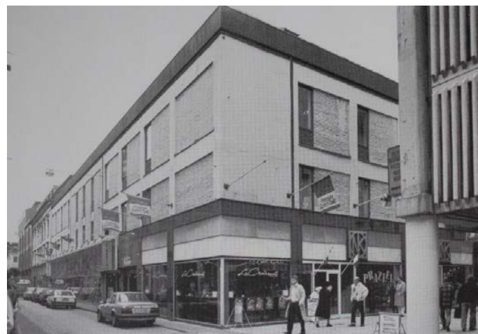
Äldre fotografi som visar det ursprungliga utförandet av fasaderna med tegelmurade fält och en bred takfotslist.
