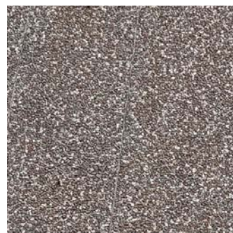
Täta fasaddelar är klädda med fasadskivor med frilagd ballast.
