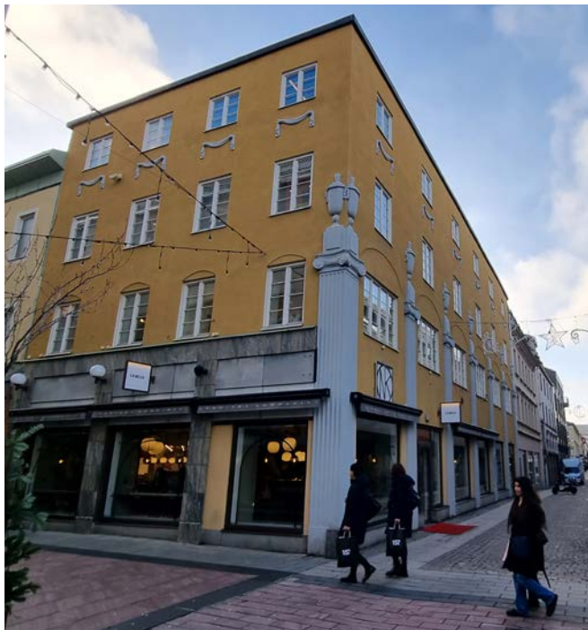
Gatufasad mot Drottninggatan/Fredsgatan. Fasaderna är relativt välbevarade i våning 2-4 med klassicerande dekor. Mot Fredsgatan har bottenvåningen omgestaltats och klätts med kolmårdsmarmor.
