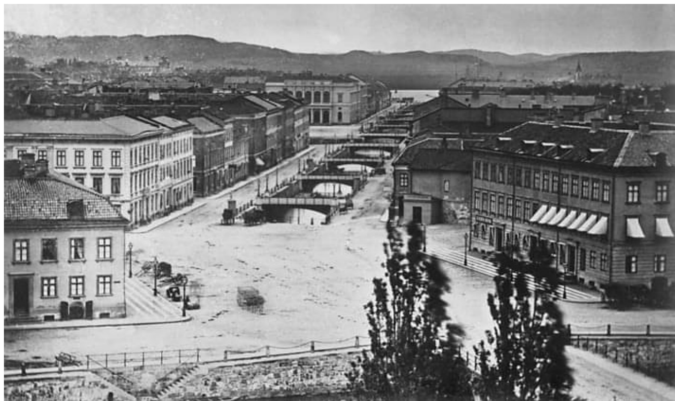
Östra Hamngatan ingick i den ursprungliga stadsplanen från 1621, då som kanal. Två smala hamngator löpte längs kanalens sidor. Gatan kantades av byggnader i 2-3 våningar. Någon jämn takfotslinje förekom inte men byggnadsmassan hade en sammanhållen låg höjdskala. Källa: Digitalt museum.
