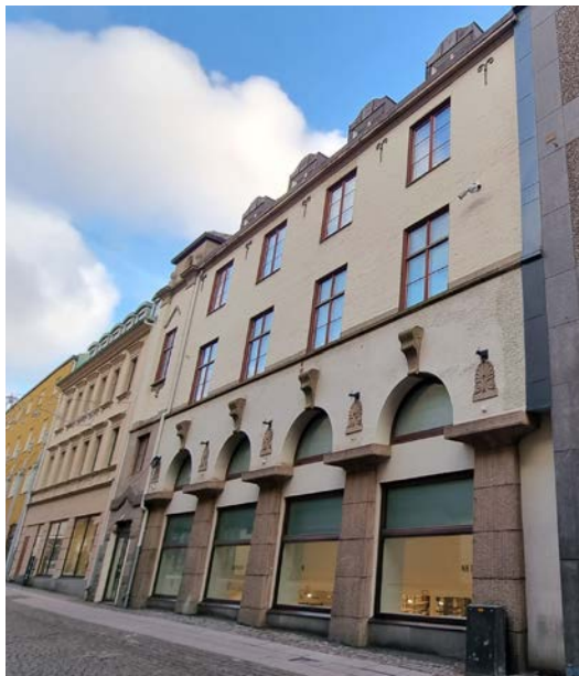
Fasad mot Drottninggatan med en till stora delar bevarad karaktär sedan omgestaltningen 1917-1922.
