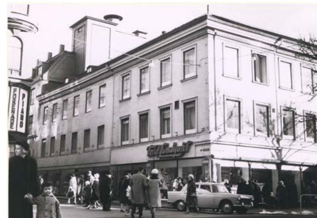
Östra Hamngatan 42 år 1955. Fasaderna har fått en förenklad karaktär. Källa: GSM
