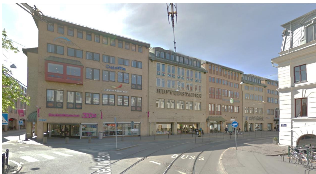
Fasad mot Södra Hamngatan
