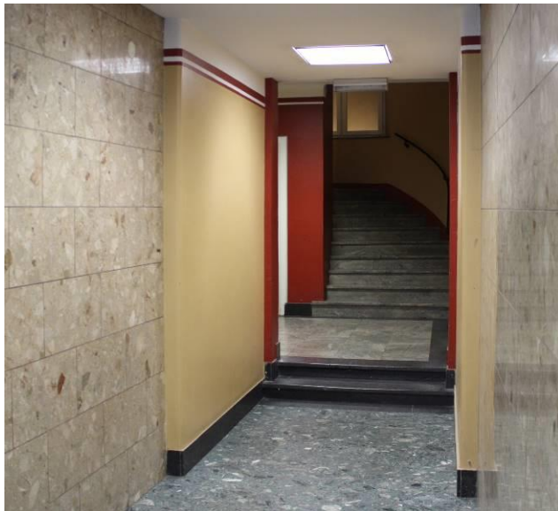
Vy från entréhall mot trapphuset. Den gröna terrazzon och de beige väggplattorna är sekundära. Den inre delen av entrén är original med putsade väggar och golvbeläggning i marmor.
