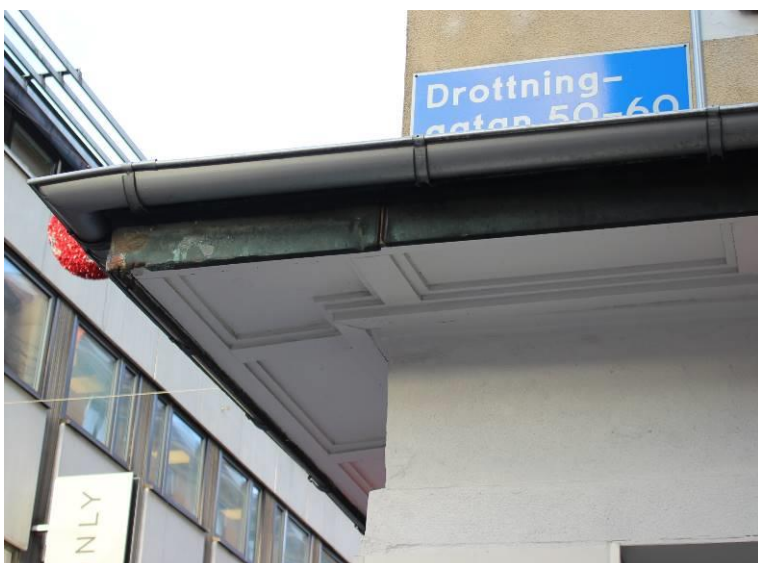
Över sockelvåningen löper ett svagt utskjutande skärmtak med profildragen puts i kassettindelning och sarg i kopparplåt. Original.
