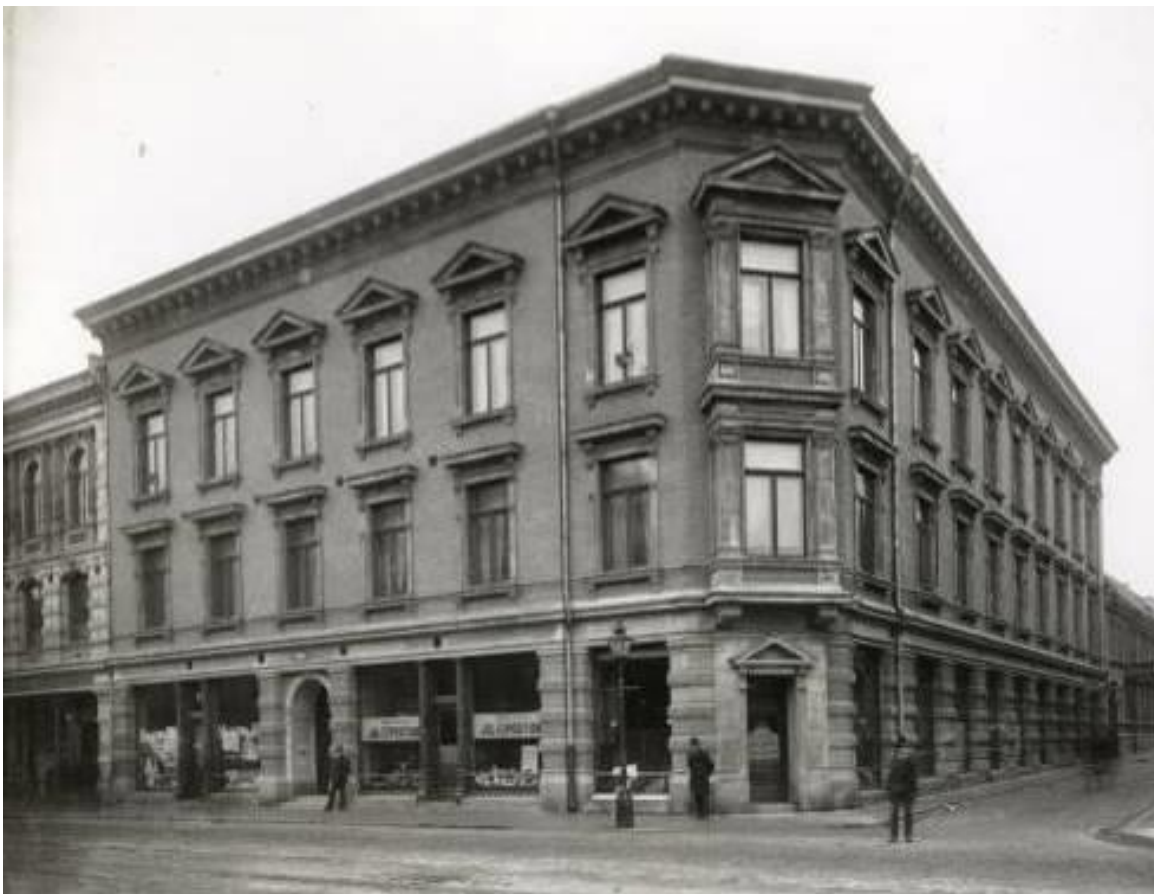
Befintlig byggnad på Södra Hamngatan 45 är ett tidstypiskt exempel på det sena 1800-talets byggande i fler våningar. Källa GSM
