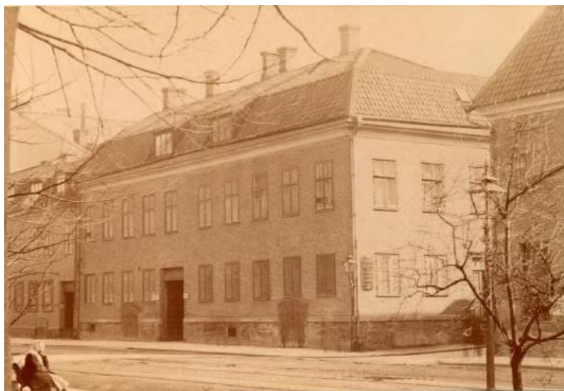
Södra Hamngatan 45 bebyggt med stenhus på 1800-talets första hälft. Byggnaden revs inför uppförandet av befintlig byggnad 1887. Detta hus och intilliggande stenhus på fotografiet är uppförda i sparsmakad nyklassicism.
