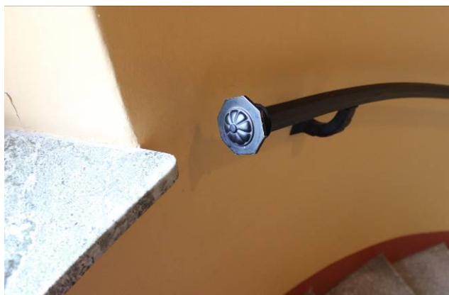
Fönsterbänk i marmor och detalj av smidesräcke.
