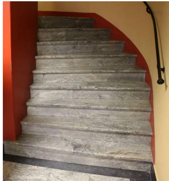
Trappa och golv i marmor, original. Smidesräcke original.
