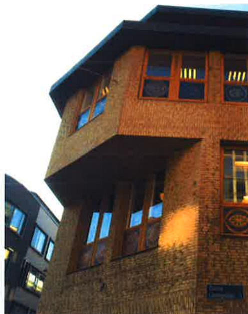
Burspråk mot Östra Larmgatan
