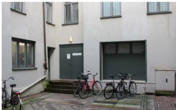
Gården sedd från portgången mot norr. Ståldörr och lastport etablerades på 1940-talet. Lastporten har satts igen och försetts med fönster. Till vänster om ståldörren har trapphusporten in till det rivna trapphuset satts igen och försetts med fönster.
