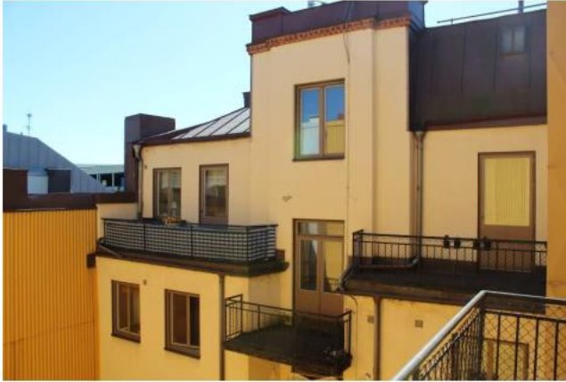
Gårdsfasad mot norr. Trapphuset skjuter upp ovan takfoten.
