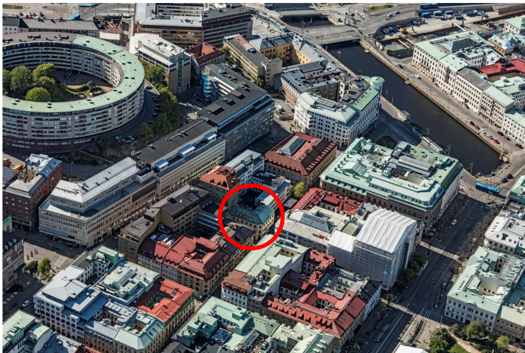
Tät stadsbebyggelse och få öppna och gröna ytor omger den berörda byggnaden, inringad i rött. Vybild från 2020.
