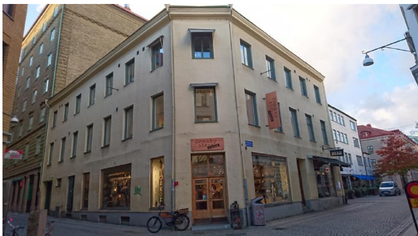
Figur 7 Berörd byggnad som avses byggas på i korsningen Magasinsgatan/Kyrkogatan.
