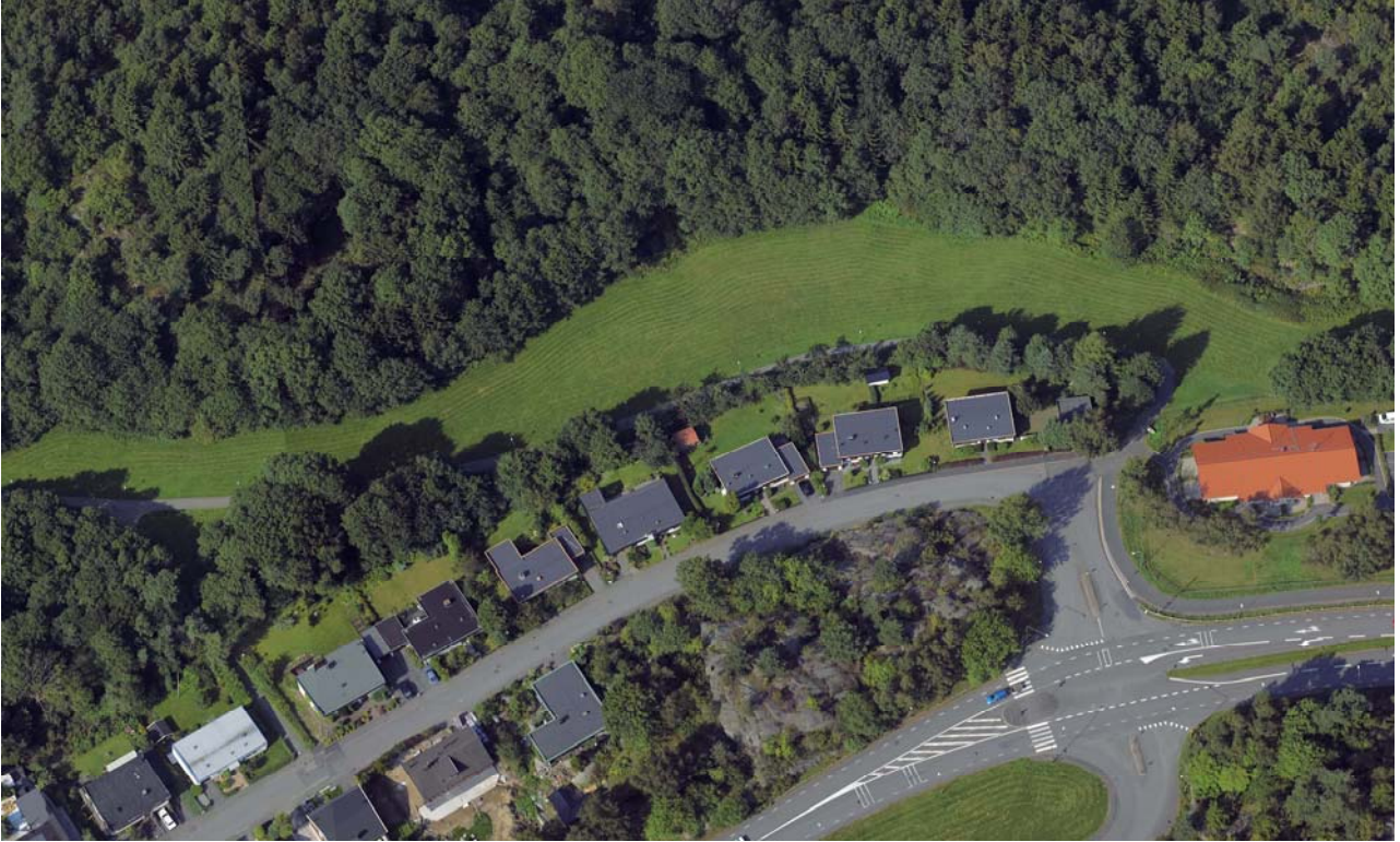
Planområdet och intilliggande befintlig bebyggelse vid Villavallen, snedbild från öster.
