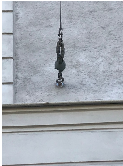
Bilderna visar exempel på infästning för kontaktledningar för spårväg på Södra Hamngatan.
