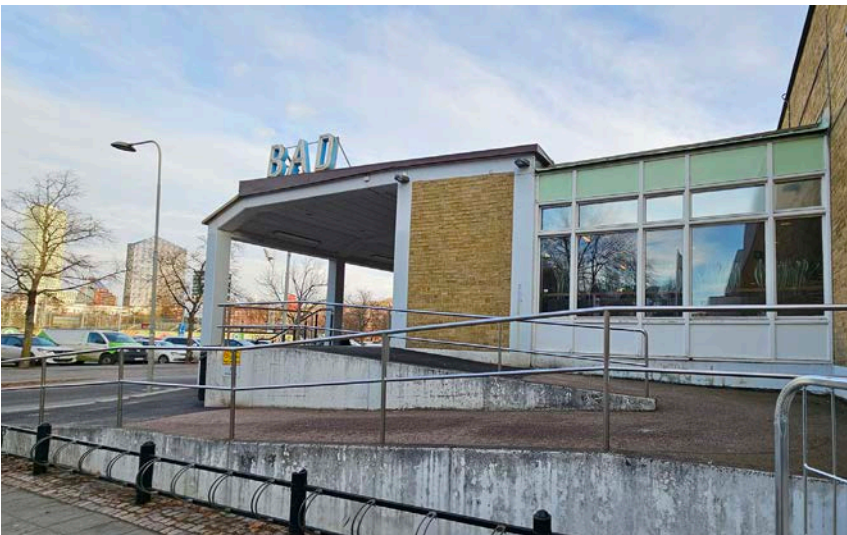
Entrébyggnaden dockas till omklädningsbyggnaden via ett ursprungligt teakparti (målat utvändigt under senare tid). Trappor och ramper upp till entrén är sentida.
