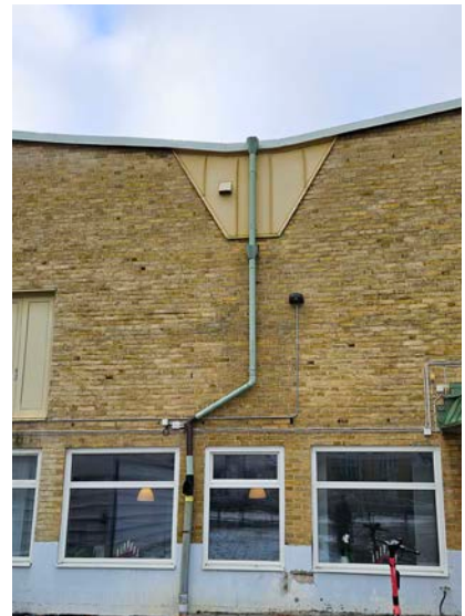
Sågtandstaket har satts igen.
