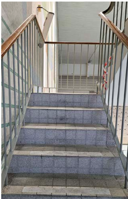
Ursprunglig trappa inne i simhallen som leder upp till solaltanen.
