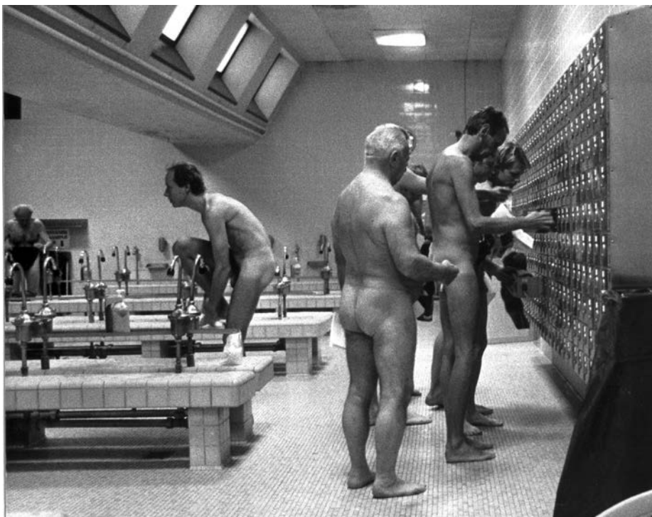
Fotografi från 1980-talet. Männens tvagningsutrymme. Här syns bl a sågtandstakets ljusinsläpp. Golvet belades med mosaik i pastellkulörer. Källa: TT
