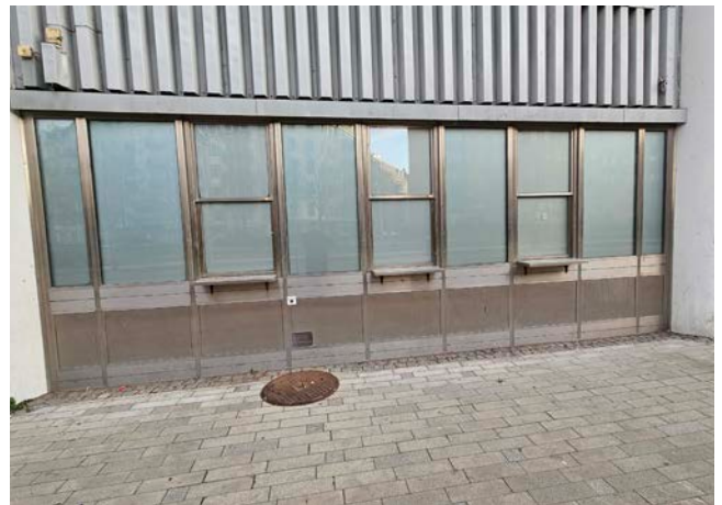
I den västra fasaden fanns ursprungligen ett indraget fasadparti i anslutning till en kiosk. Detta parti har under 2000-talet flyttats ut och ersatts med ett parti av rostfri plåt.
