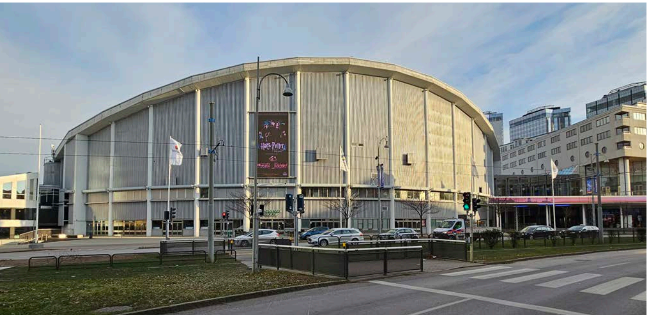
Fasad mot väst, mot Skånegatan. Till höger i bild syns hur Svenska Mässans kongressbyggnad har dockats mot Scandinavium.
