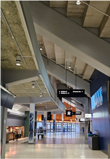
Det västra entresolplanet betraktat från den nedre foajén.
