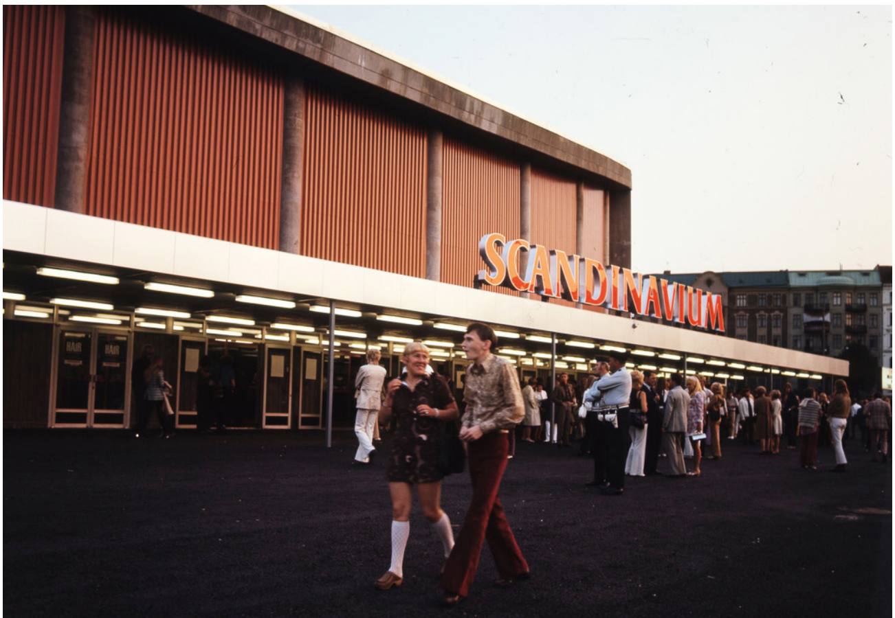
Detalj av huvudentrén år 1971 med det utskjutande skärmtaket vilket var försett med belysning. Här syns även ursprungliga entrédörrar i huvudentrén, vilka var av aluminium men fick en mer bearbetad utformning än övriga entrédörrar. Källa: TT
