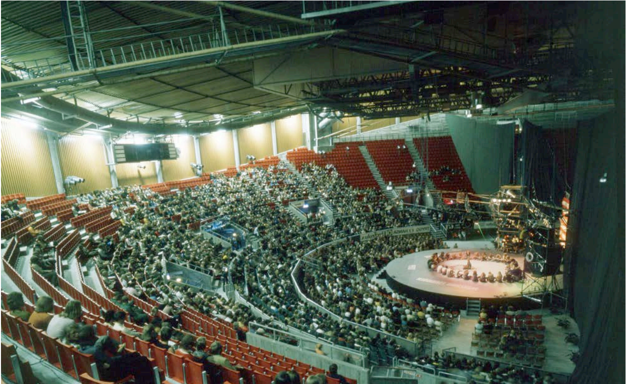
Scandinavium invigdes 1971 med en filharmonisk konsert följt av en uppsättning av "Hair". Utfackningsväggarna utfördes med korrugerad plåt lika exteriören. På fotot syns hur samtliga betongdelar ursprungligen var omålade. Åskådarplatserna var försedda med stolar av orangeröd plast. Hängtakets kabelsystem lämnades synligt. Källa: TT
