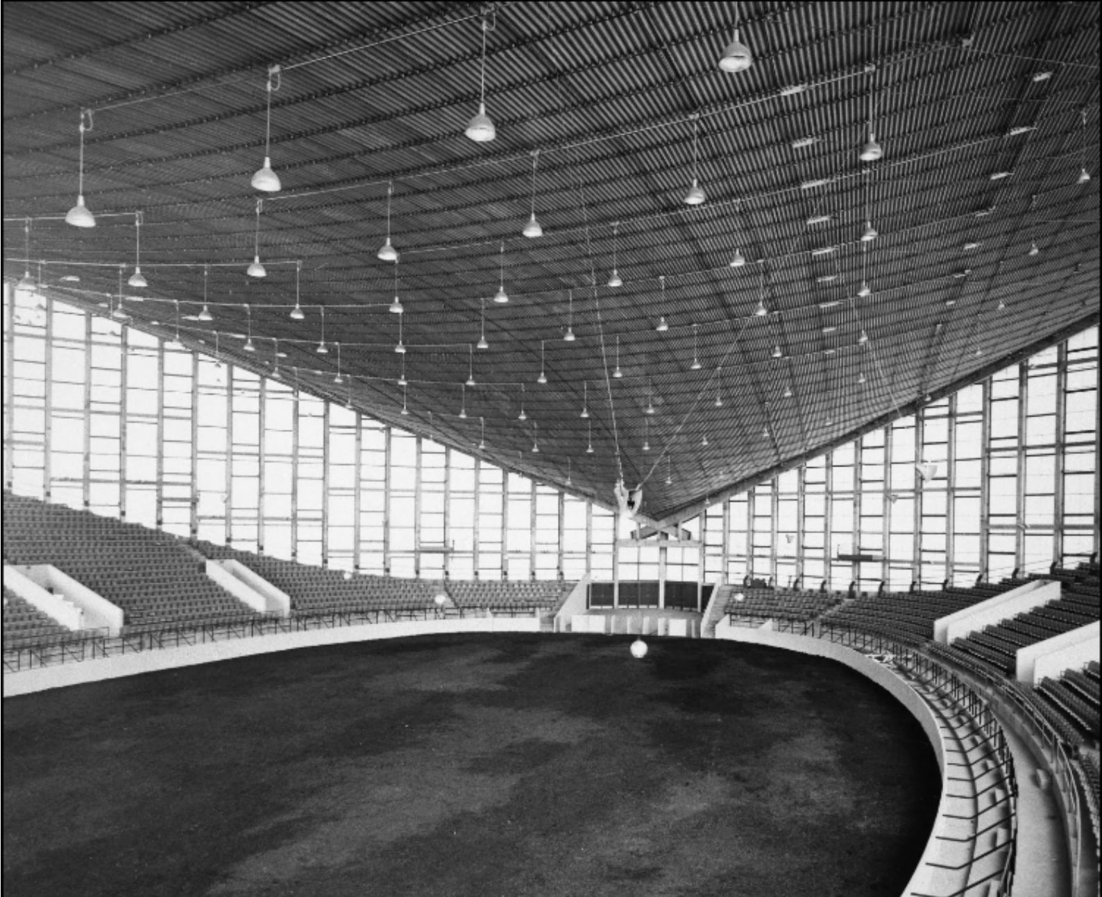
Interiör i Dorton Arena i North Carolina, USA, som invigdes 1952 och utformades med ett dubbelkrökt tak lika Scandinaivum. Källa: State Archives of North Carolina Collection 4.1
