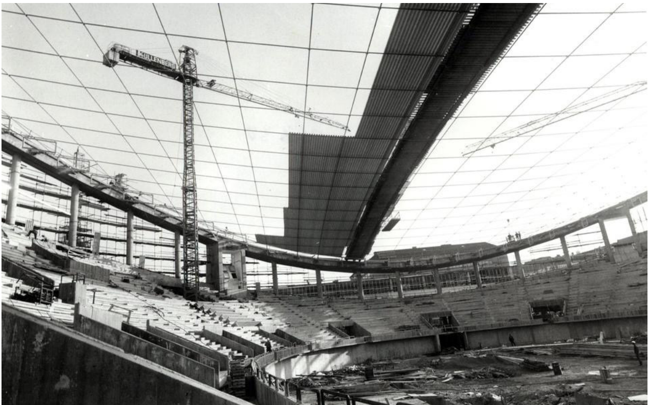
Hängtakets bärande kablar är på plats. Källa: Byggmästaren år 1971
