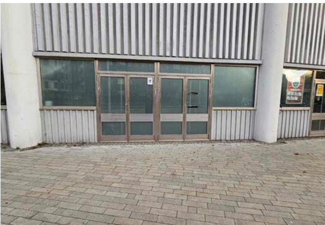
Detalj av ett av den västra fasadens entrépartier bestående av dubbla pardörrar med överljusfönster samt fasta sidopartier ovan den trapetsgjutna sockeln. Samtliga pardörrar är sentida.
