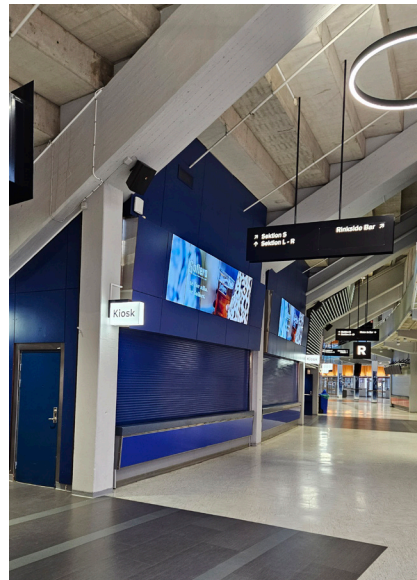
Kiosker, förråd och toaletter är inrymda mellan huvudbalkarna. Samtliga väggar är sentida av modernt skivmaterial.
