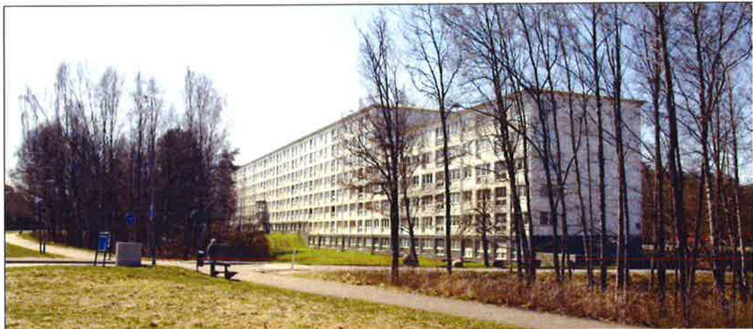
Ombyggt skivhus vid Hammarkullegratan.
