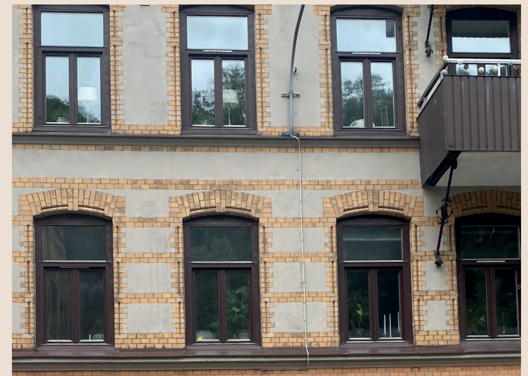
Tegelomfattningar kring fönster.
