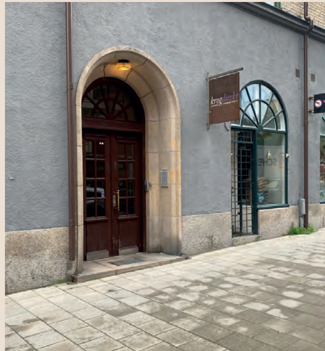
Indragen trapphusentré med stenomfattning
