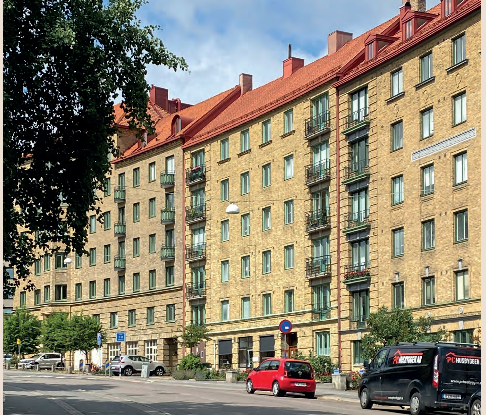
Byggnader inom kvarteret på Rosengatan.
