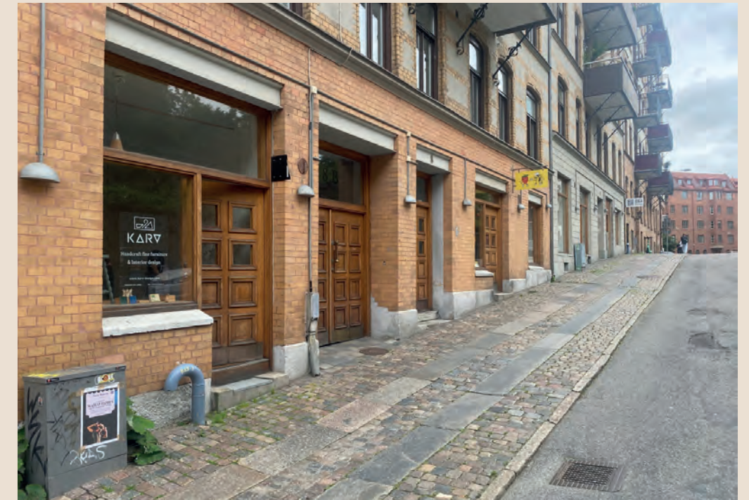
Lokalentré och skyltfönster med stålbalk i ovankant
