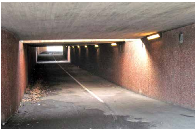
Gång- och cykeltunneln under Dag Hammarskjöldsleden.
