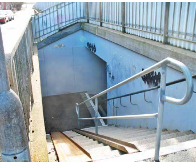
Gångtunnel med låg tillgänglighet i höjd med Marklandsgatans hållplats.
