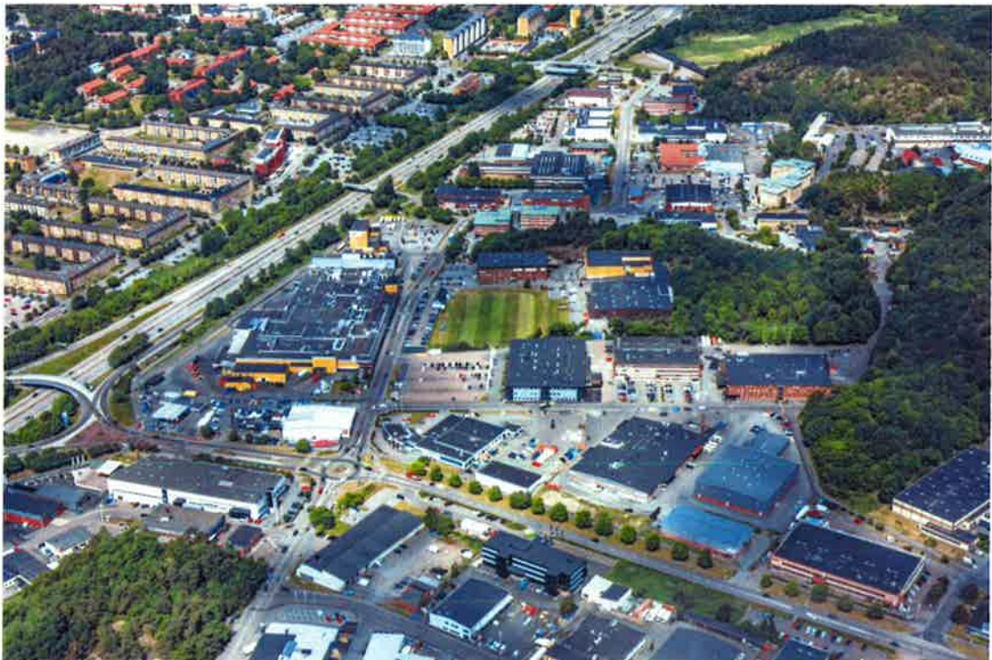
Planområdet sett från söder, idag har ett flertal byggnader rivits.
