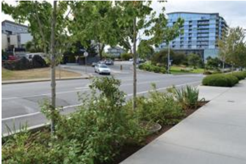
Figur 23: Exempel på ett biofilter i vägmiljö (City of Victoria, 2017).
