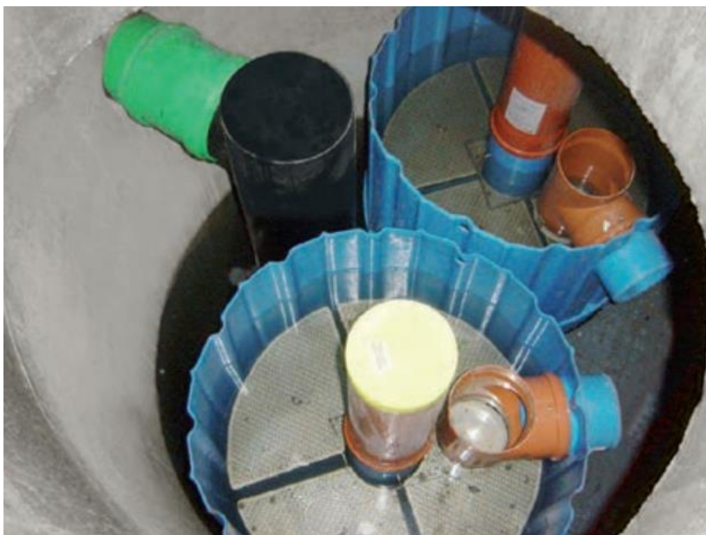
Figur 20: Exempel på filterbrunn för rening av dagvatten av typen "Hydrosystem" (Rent Dagvatten, 2017).
