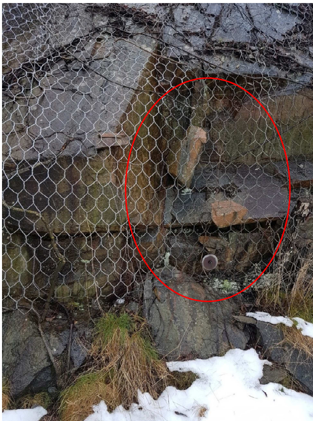
Figur 8 Område där rensning av lösa block bakom befintligt nät behöver utföras.
