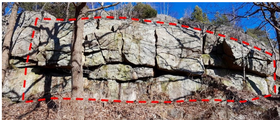
Figur 15. Den södra delen där vajerförstärkt bergnät ska monteras.
