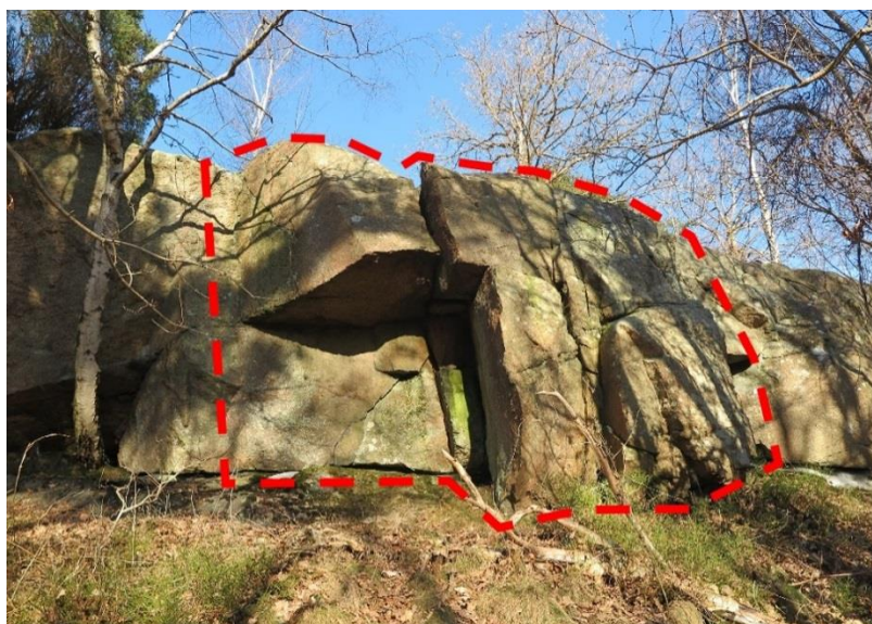
Figur 16. Den norra delen där vajerförstärkt bergnät ska monteras
