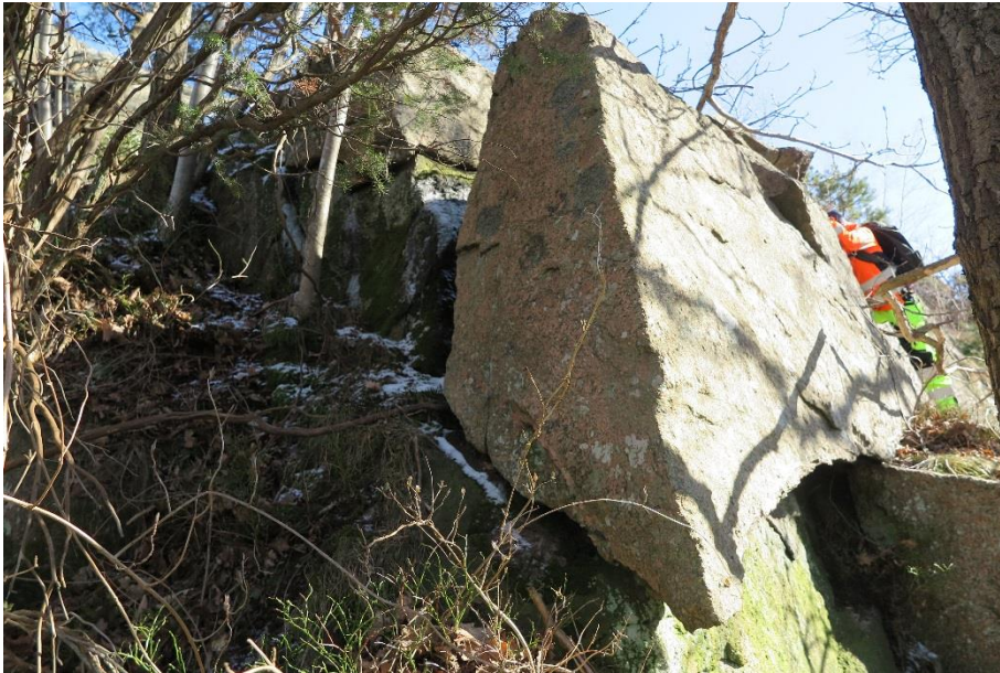
Figur 13. Löst block med mycket begränsat stöd.
