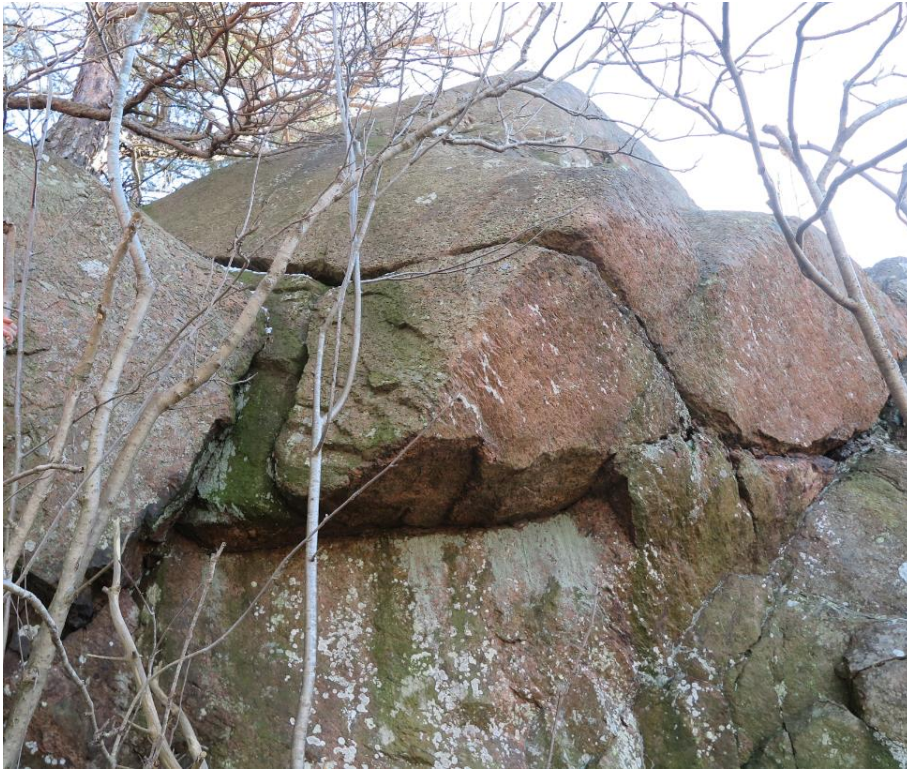
Figur 10. Löst block som hålls på plats av en mindre bergklack.
