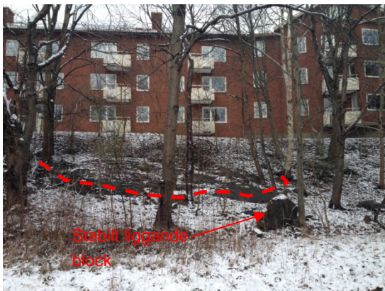
Foto 1. Berghäll i området och ett mindre stabilt block
