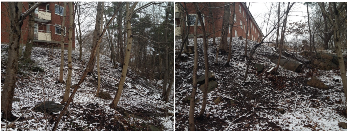
Foto 5 och 6. Befintlig fyllnadsslänt med framstickande berg och stabilt liggande block
