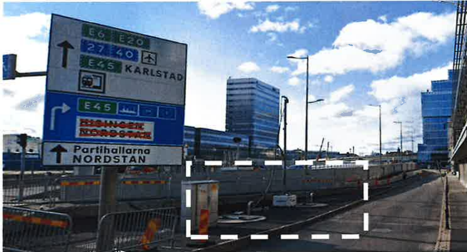
Figur 48: Bild visar befintlig spillvattenpumpstation vid Kilsgatan.
