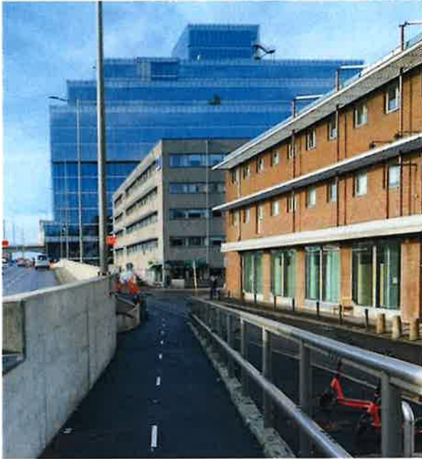
Figur 29: Foto visar den stödmur som finns mellan Märten Krakowgatan och hur nivåskillnaderna skiljer sig åt mellan stödmuren, Gång- och cykelvägen och Kilsgatan.
