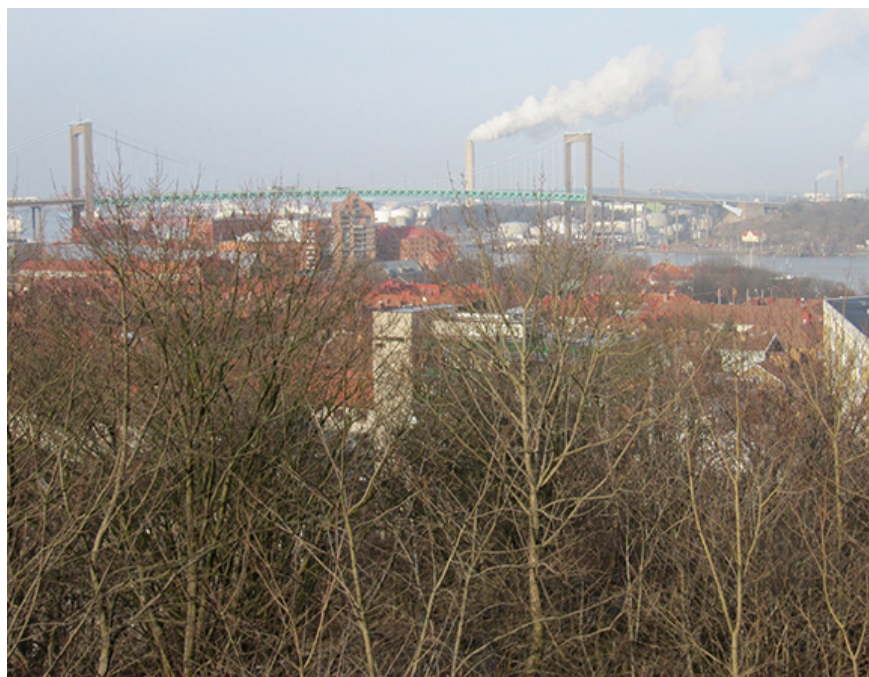
t.v. bilder från stigens början vid äldreboendet och lekplatsen. ovan: utsikt från berget mellan område A och B.
