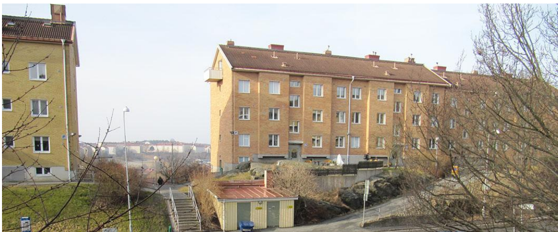
Lamellhusen längs övre delen av Ärlegatan vid område A.
