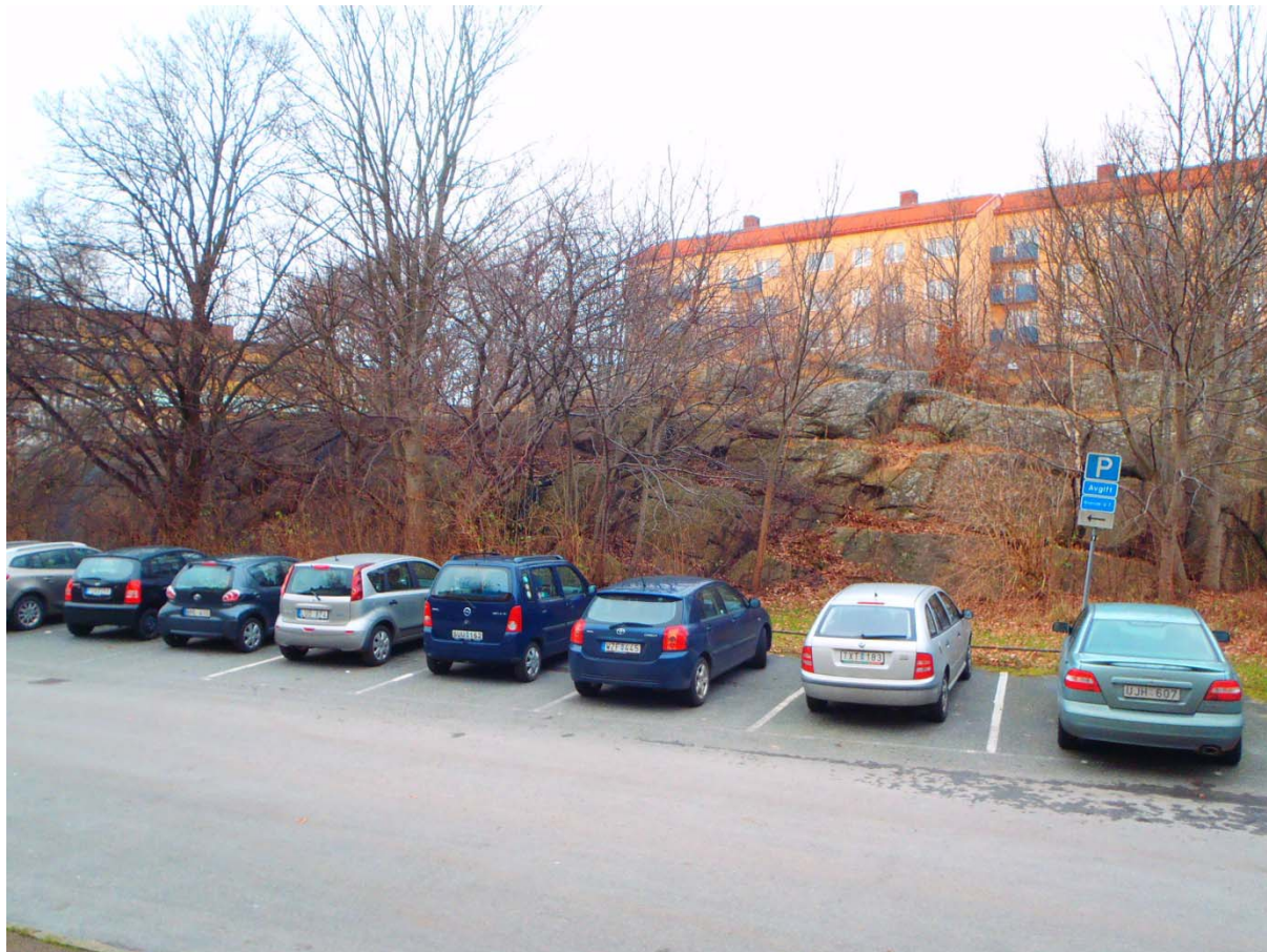
Foto 1. Delområde 2, vid parkeringen längs Ärlegatan. Bilden är tagen mot öster. Bergslänten definieras av sprickor i sprickgrupp 1 och är idag stabil.
