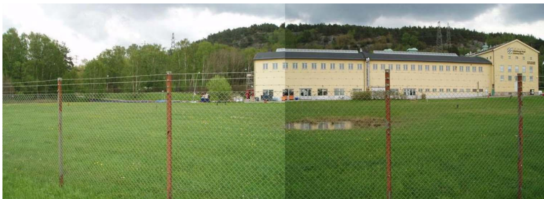
Vattenverket sett från Gamlestadsvägen
