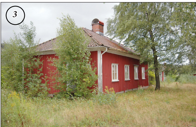
3 Stationshuset i Lärje står kvar men Västkustbanan är borta. Byggnaden är i stort behov av underhåll.
