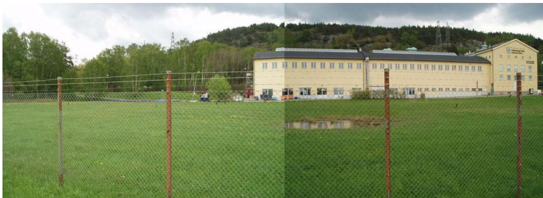
Vattenverket sett från Gamlestadsvägen
