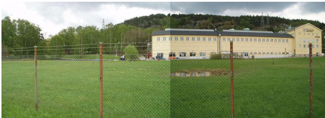
Vattenverket sett från Gamlestadsvägen
