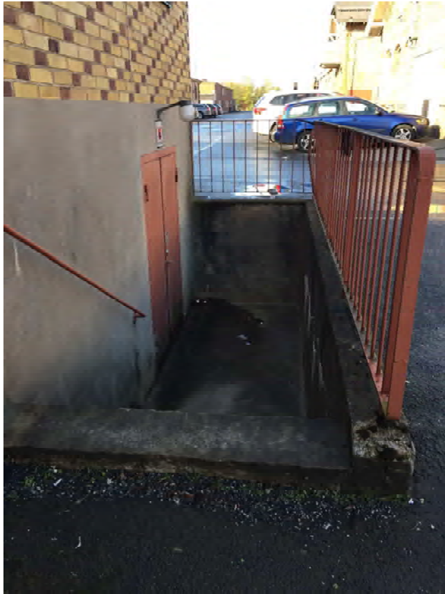
Figur 12. Nedgång till källare
