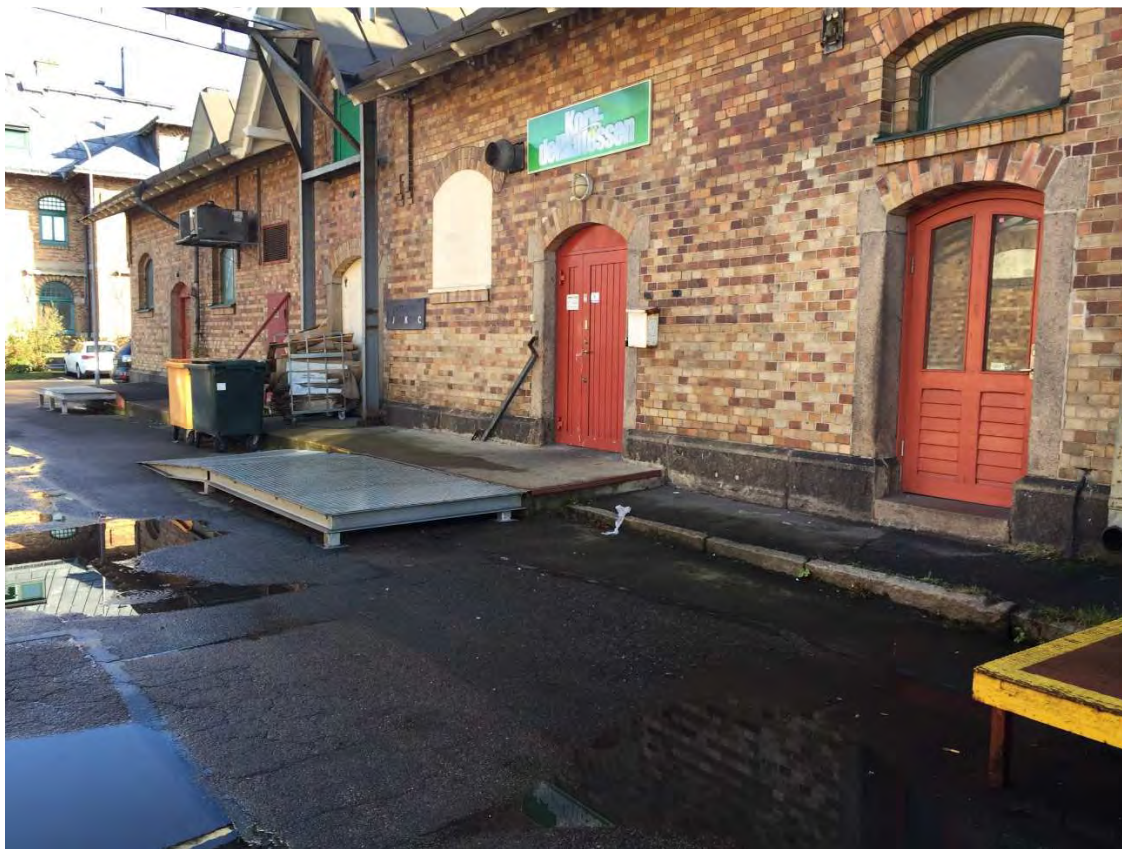
Figur 9. Bilden visar att ingången i husen ligger ganska högt över markytan.
