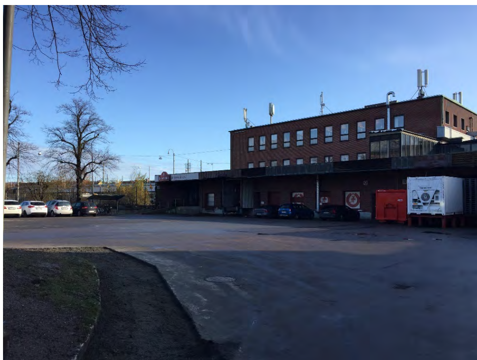
Figur 12. Bilden visar en av de mest översvämningsdrabbade ytorna vid skyfall. En lågpunkt i den östra delen av utredningsområdet.
