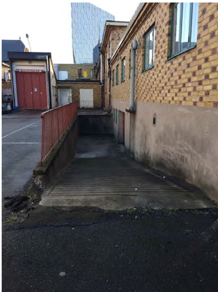
Figur 11. Nedgång till källare
