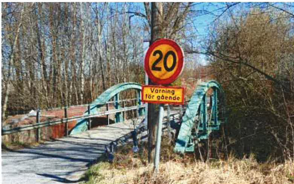
Bron över Lärjeån (Foto: Sweco)
