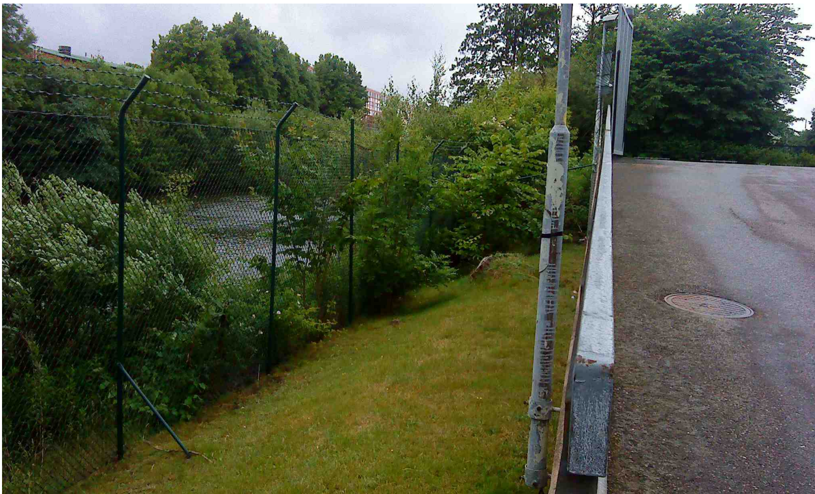
Figur B.1.2 Fotografi tagen vid Kullagergata i västlig riktning längs stödmur vid Säveåns norra sida (Delområde A).
