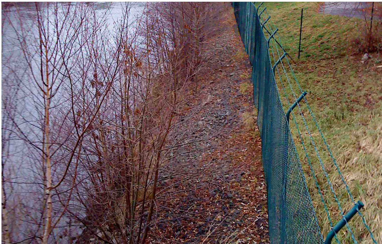
Figur B.1.16 Fotografi tagen från Ryttnästarebron västlig riktning över erosionsskydd vid Säveåns norra sida (Delområde D).
