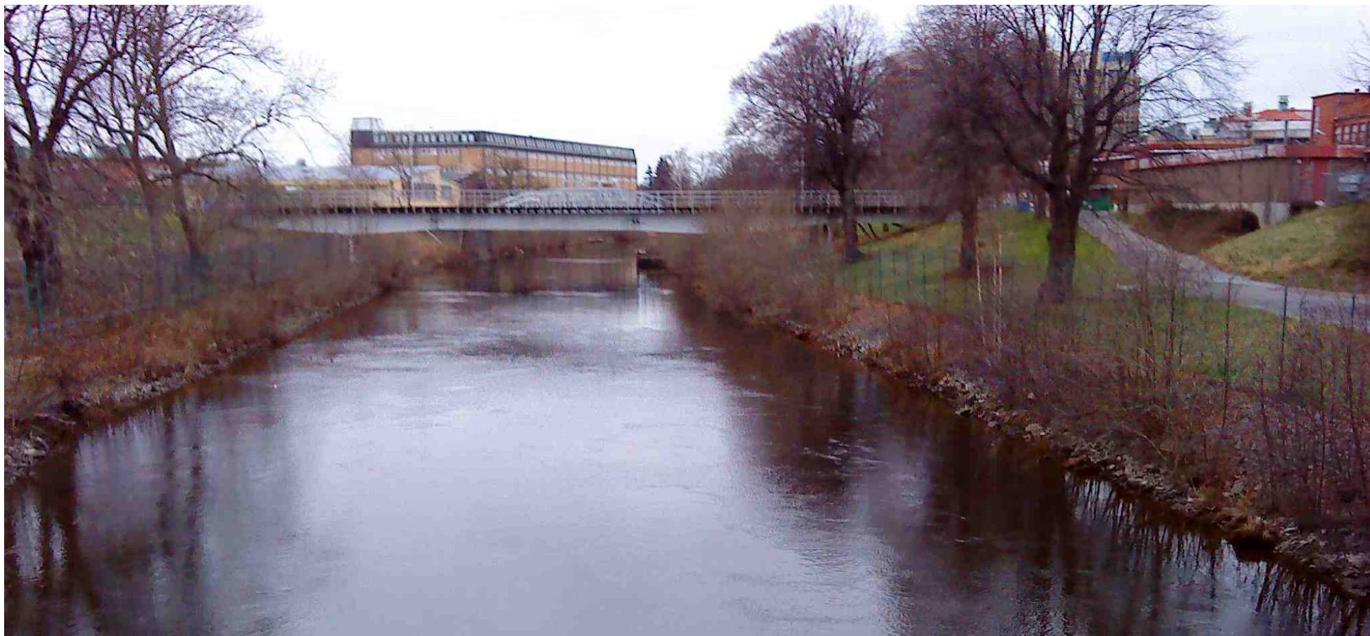
Figur B.1.15 Fotografi tagen från Ryttmästarebron västlig riktning med befintlig erosionsskydd vid Säveåns norra sida på höger sida (Delområde D).
