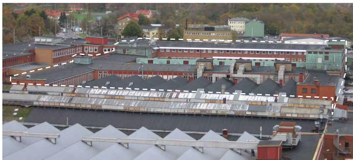
S-fabrikens taklandskap. Sågtandstaket syns framför mittbyggnaden och lanternintaket skymtar bakom.
