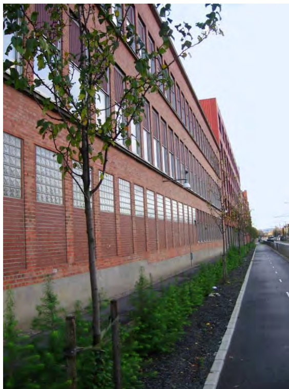
Första våningen har igenmurade fönsteröppningar med betongglas och tegel.
