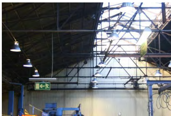
Plåtklädd vägg delar härdbyggnaden i två hallar.
