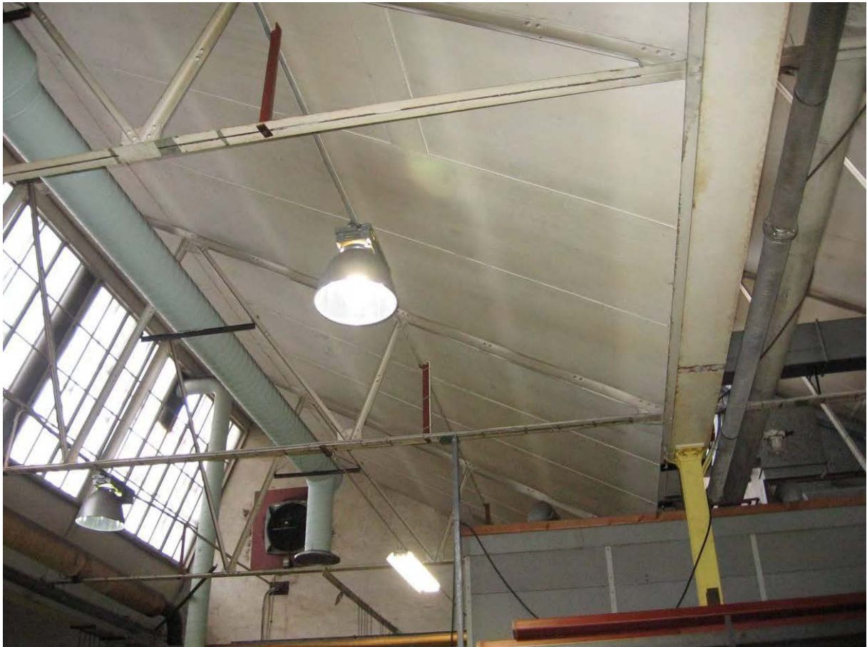
Sågtandstaket uppburet av smäckra takstolar i stål, I-balkar och stålpelare.
