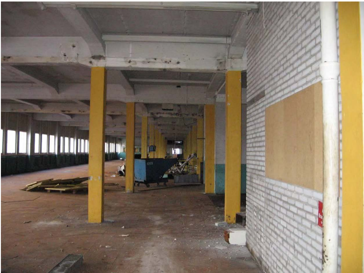
Öppen planlösning med bärande betongpelare. Utbytta fönster mot Artillerigatan syns till vänster i bild.
