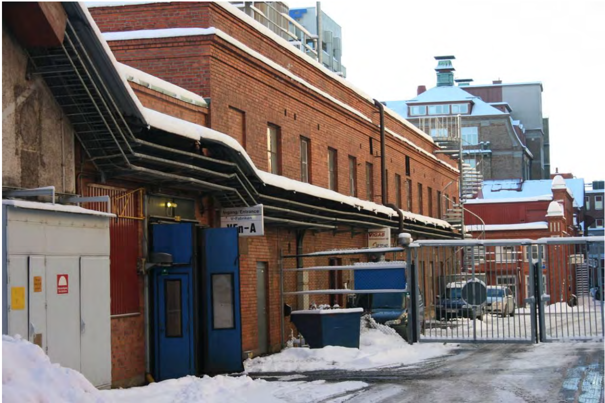
R-fabrikens norra fasad. Närmast i bild skymtar Härden och därefter sammanbyggnaden av de båda fabrikerna och det som tidigare utgjorde femte tvärgatan. Kabelstegar löper över samtliga fasader.
