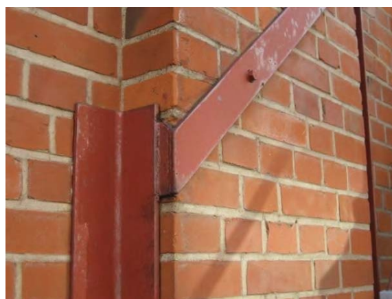
Prydlig anslutning till tegelfasaden.
