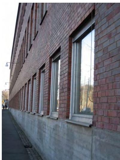
Den långsträckt fasaden förmedlar känslan av en fabriksbyggnad.
