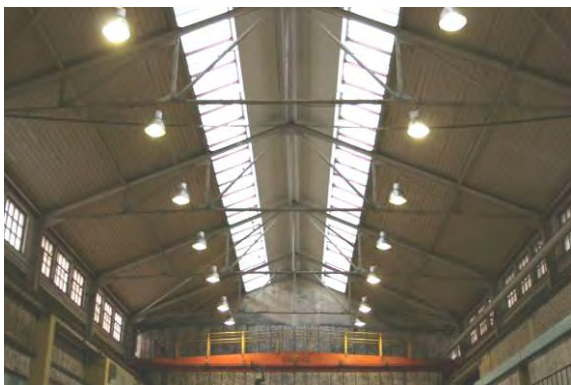
Synliga takstolar, fönsterband och takfönster i lanternintaket samt travers i mitthallen.
