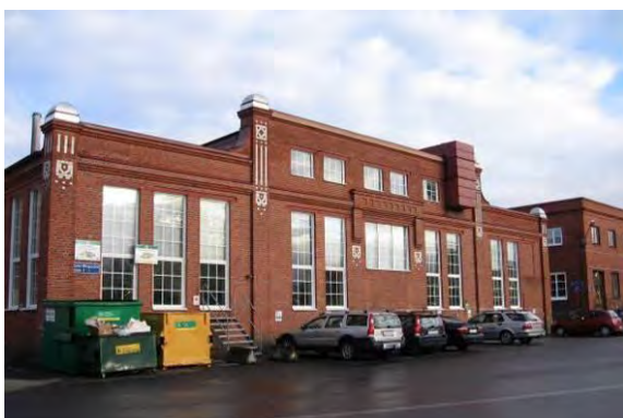
Östra delen – gavel mot söder
