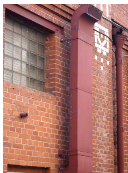
Många installationer är gjorda med påfallande omsorg om fasaduttrycket.
