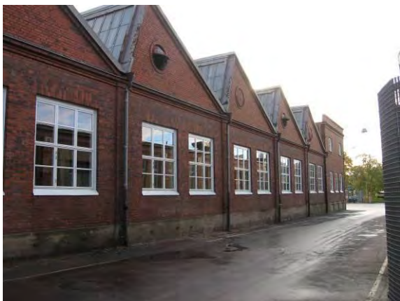
Västra fasaden med enplans- och tvåplansdel.
