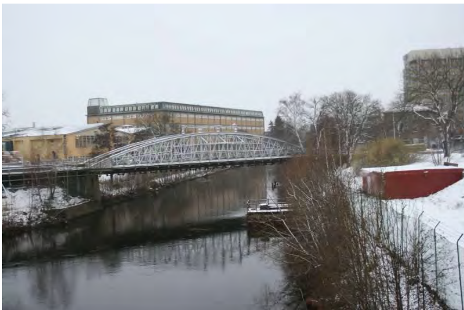
Järnvägsbron över Säveån, invigd 1916.
