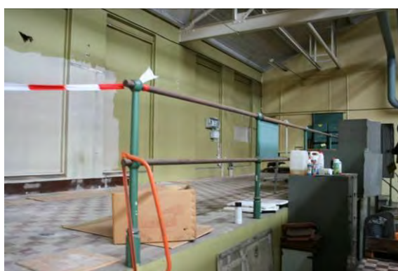
Avsats i anslutande sidoskepp, hallens västra sida. Igensatta fönster i västra fasaden.
