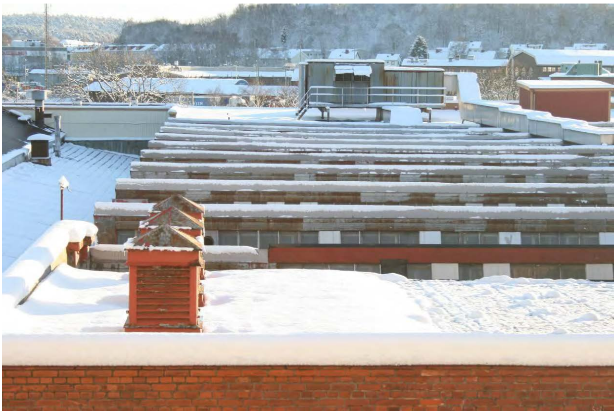
Sågtandstakets östra del sett från norr. Fläktrum med tillhörande ventilationskanaler syns på takets södra del.
