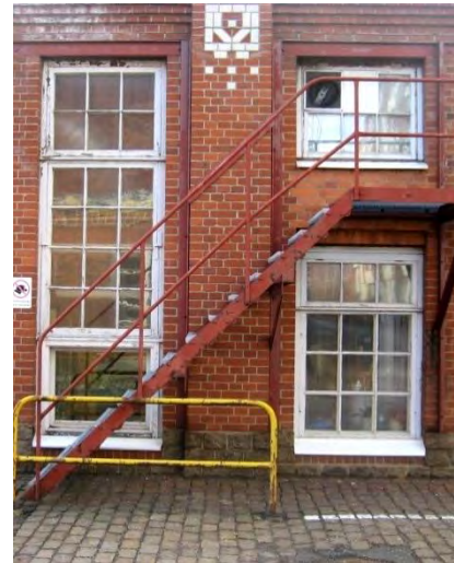
Till vänster i bild en fönsteröppning av originalstorlek. Till höger ändrad för att passa en ombyggd interiör.
