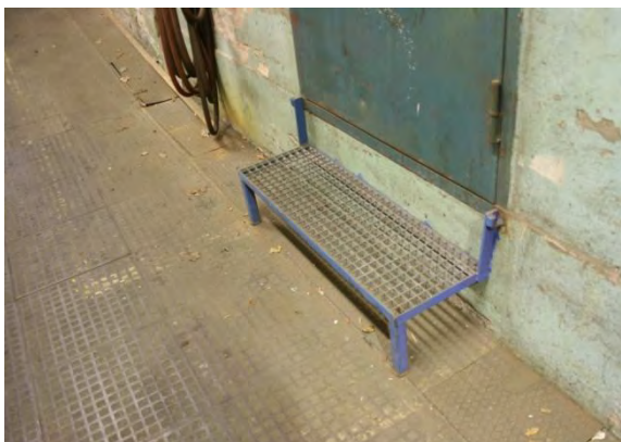
Enkelt trappsteg med durkplåt.
