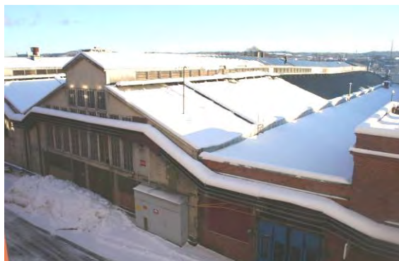
Tak över västra härdbyggnaden. Där snön har smält på taket pågår fortfarande verksamhet.
