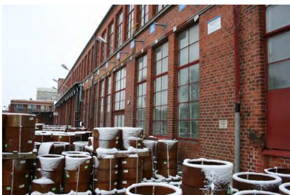
Svarv II, fasad mot söder.
