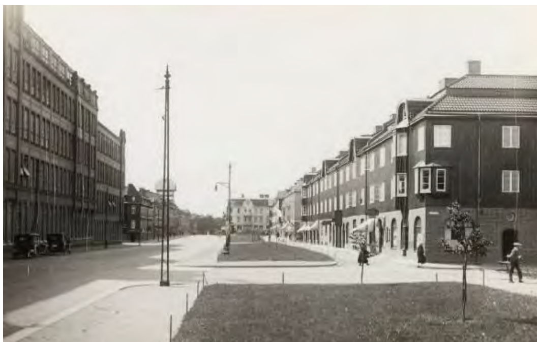
Gamlestaden – brukssamhälle i storstadens utkant. SKF:s fabriker till vänster i bild. I nära anslutning till fabrikerna låg bostadsbebyggelsen, i huvudsak bestående av landshövdingehus. Bild från 1935. Bildkälla: Göteborgs stadsmuseum.
