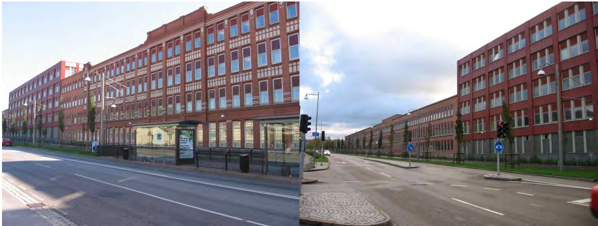
Fasader utmed Artillerigatan – A-, K-, och C-fabriken.
