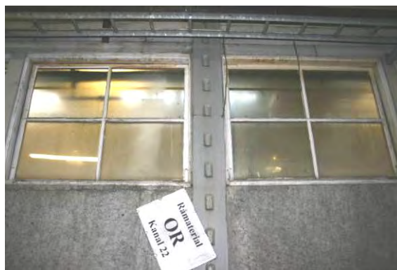
Kringgjutna stålpelare samt kvadratiske fönster med spröjs byggdes om kring 1960.
