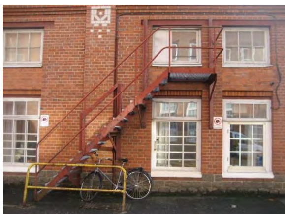
Utanpåliggande rödmålad trappa på M-fabrikens norra fasad.
