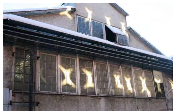
Gavel mot norr med tre fönsterrader varav den mittersta döljs av elstegar.
