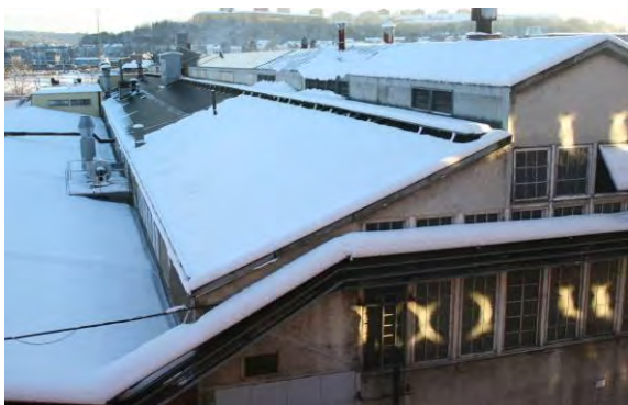
Tak över östra härdbyggnaden, till vänster syns taket över Sjötte tvärgatan.
