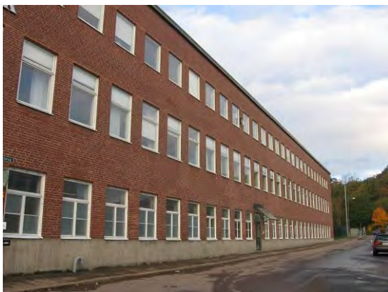
Fasad mot Ryttmästaregatan.
