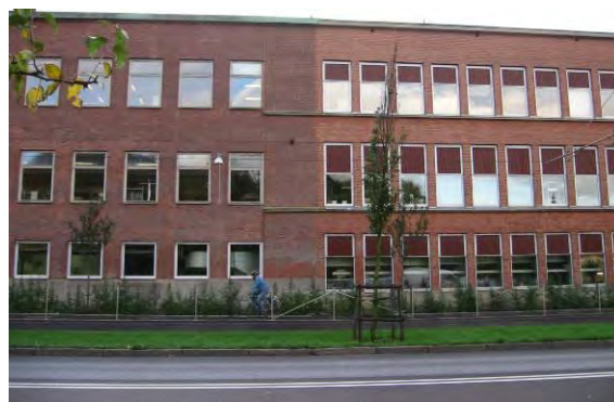
Synlig skarv mellan tillbyggnad och ursprunglig byggnad.
