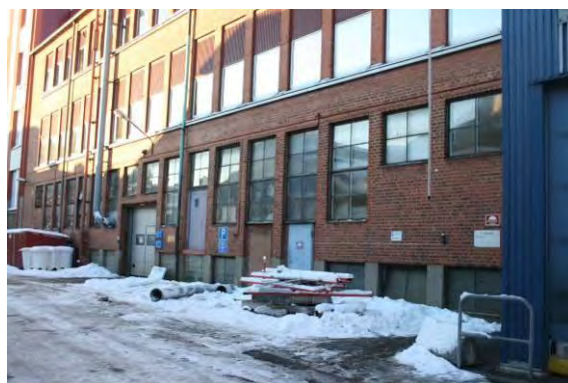
Originalfönster i bottenvåningen.
