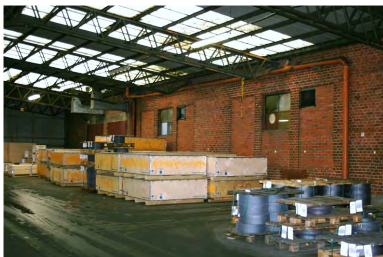
Svarv I, fasad mot väster. Fönstren är igenmurade, möjligen efter överbyggnaden av Sjätte tvärgatan 1960.
