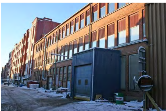
C-fabrikens fasad mot Rullagergatan.
