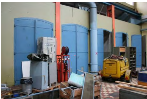
Hallens östra sida. Sidoskeppet är avdelat och portar i plåt leder in till separata utrymmen.
