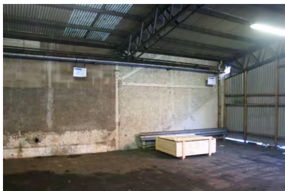
Putsad fasad med synlig stålkonstruktion till höger i bild är originalutförande.
