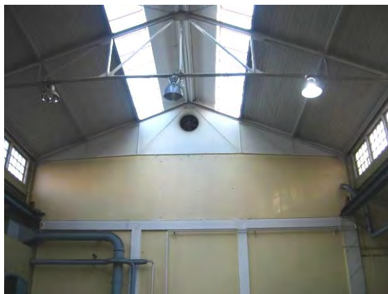
Fackverkstakstol, f d kraftcentralen.
