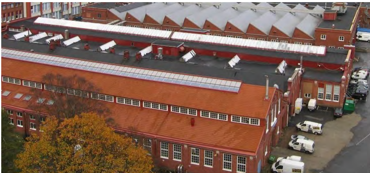
M-verkstadens taklandskap. Närmast i bild västra delens synligt fönsterband i anslutning till övre delen av taket, därefter västra delen med glasade lanterniner och igensatt fönsterband. I bakgrunden skymtar R-fabrikens sågtandstak.
