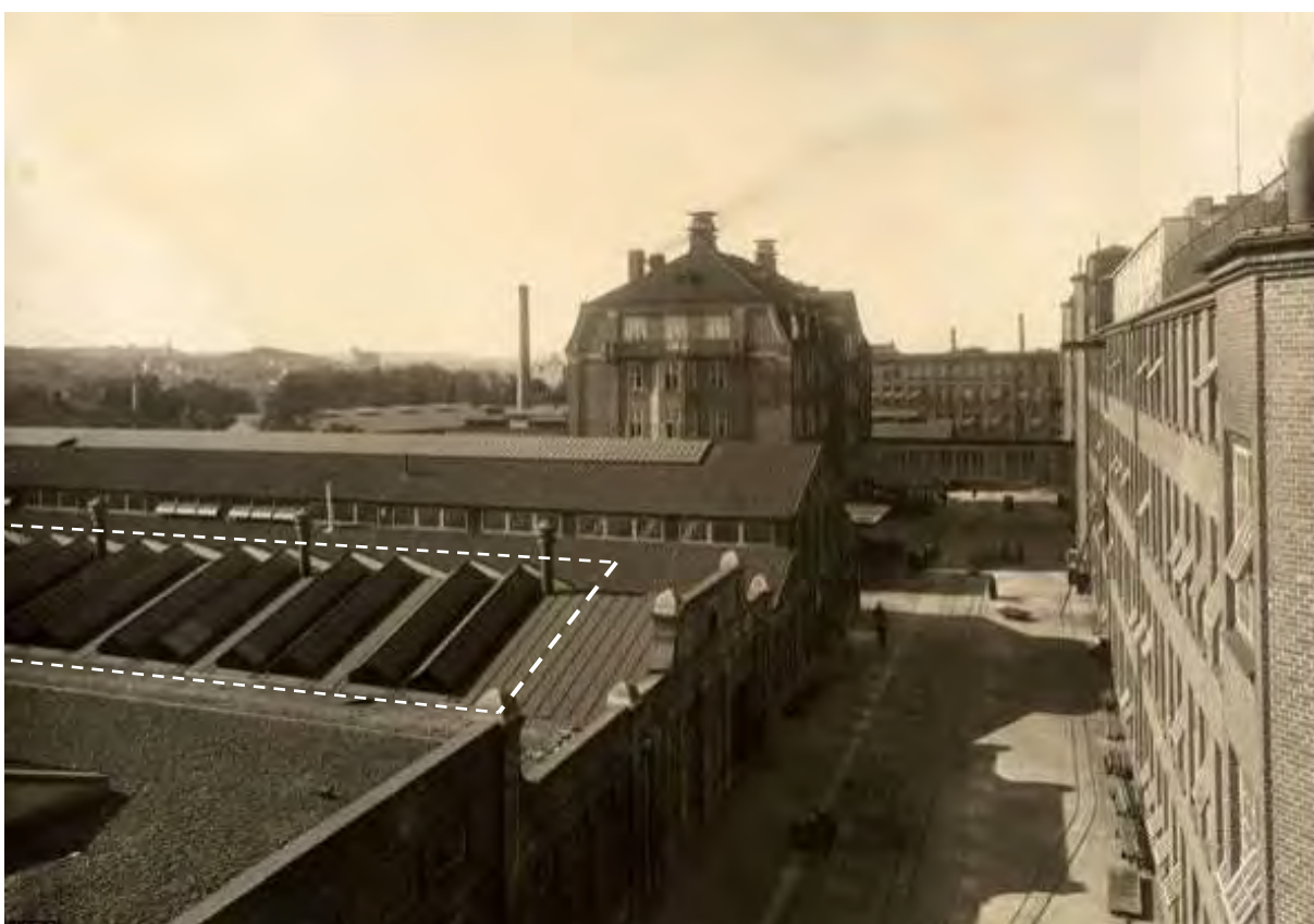
M-verkstadens taklandskap 1922, sett mot väster från Rullagergatan. Mittpartiets ursprungliga takutformning är markerad. Bild: Göteborgs Stadsmuseum
