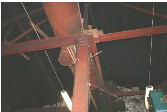
Takstolen hålls upp av pelare i stål.
