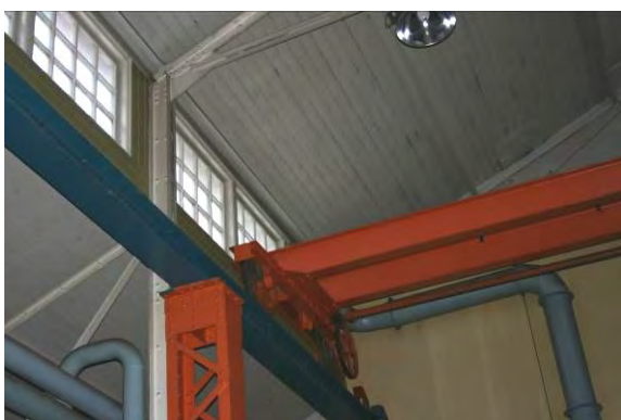
Taktravers, spröjsade fönster i lanterninen samt bärande, rödmålade stålpelare.
