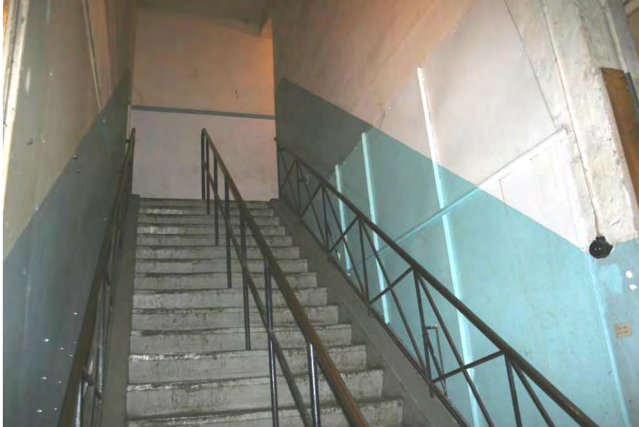
Trappa med smidesräcken leder upp till övervåningen.
