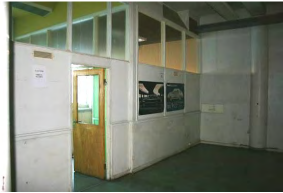
Äldre inredning, lättväggar med glasad överdel.
