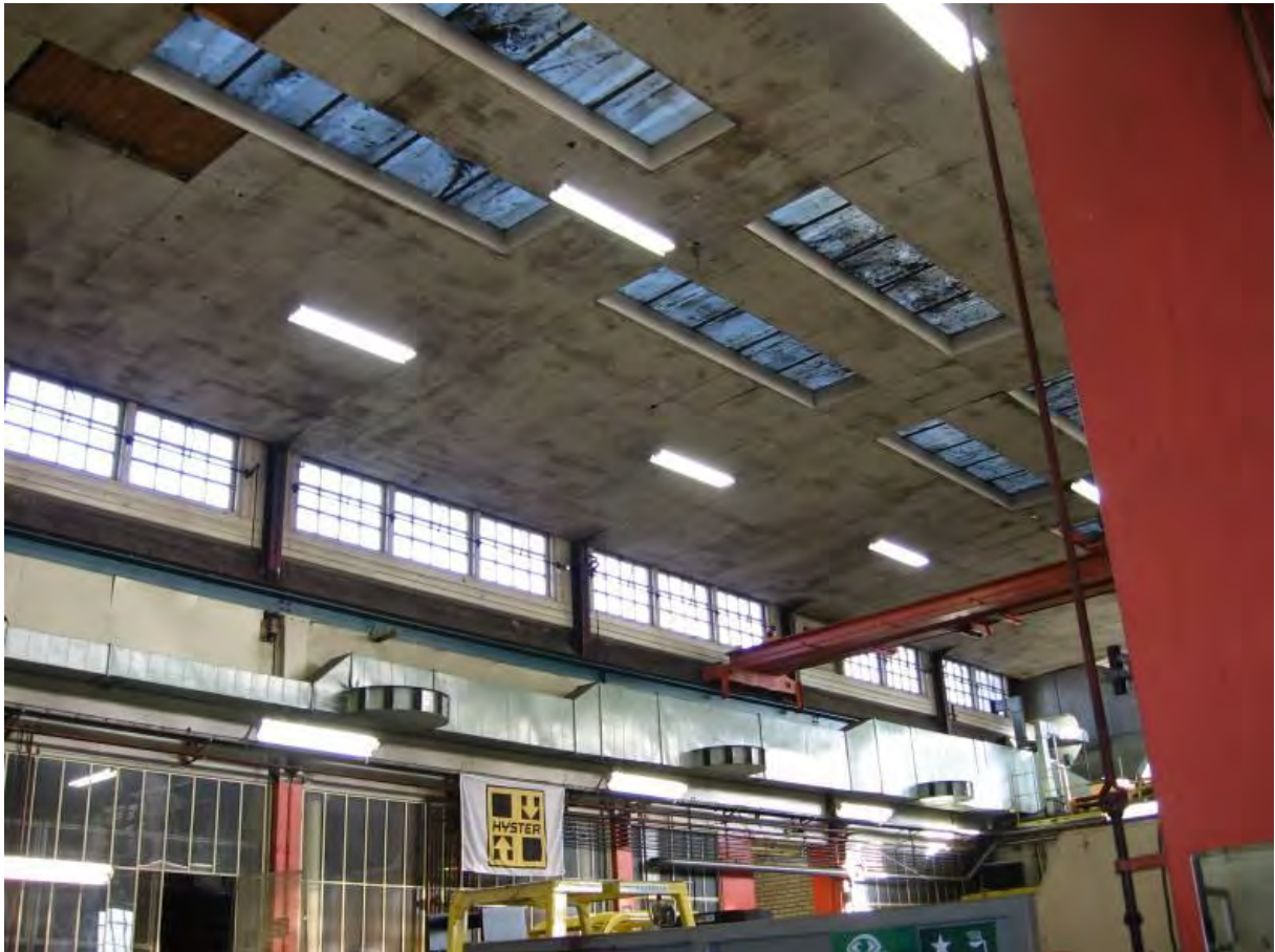
Lanternintakets fönsterband liksom traversen är bevarade. Det senare tillkomna undertakets armerade trådglass leder in ljus uppifrån.
