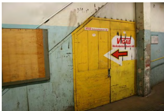
En plåtdörr med kapat hörn som infogats under trappan.
