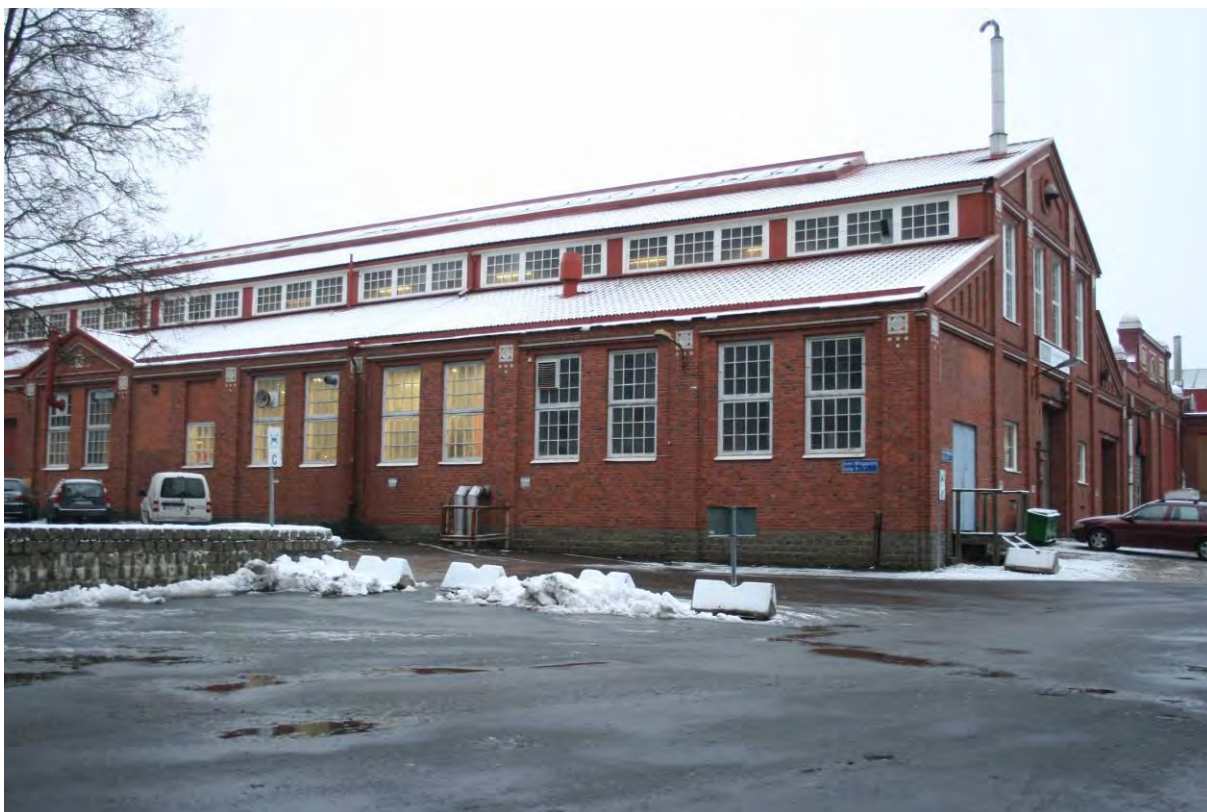
M-verkstaden - Fönster, murverk i rött tegel med mönstermurning och dekorationer, markerade gaveluppbyggnader samt lanternintak är karaktärsskapande för byggnaden.
