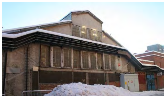
Kabelstegar och ventilationsanläggningar - tekniska detaljer som utgör senare tillägg men är viktiga för läsbarhet av områdets industrihistoria.
