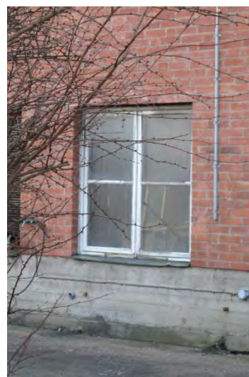
Ett kvarvarande originalfönster mot öster.
