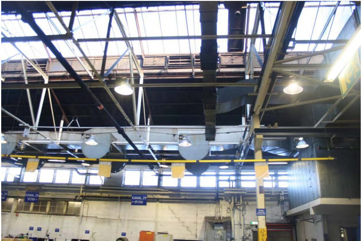
Smäckra takstolar i fackverkskonstruktion samt lanternintak.
