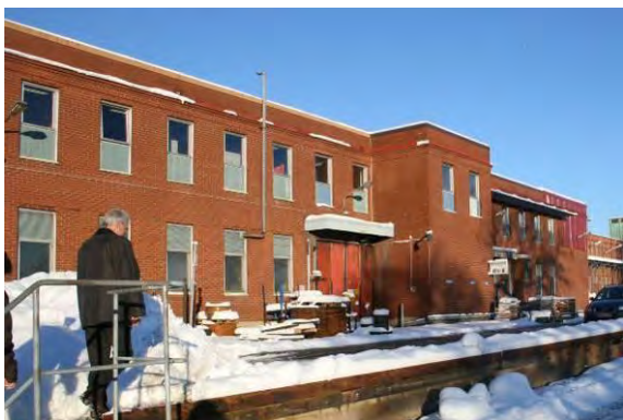
Tillbyggnad i två våningar möt söder uppförd 1971-1974.
