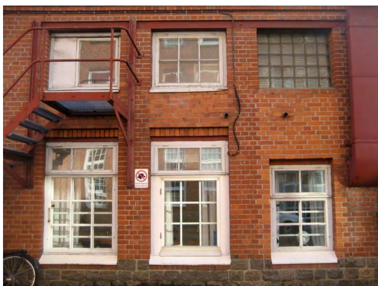
Olika fönstertyper och ljusare tegelpartier ger levande och berättande fasader.
