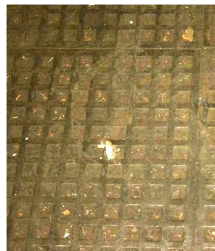
Detalj av gjutjärnsgolv.
