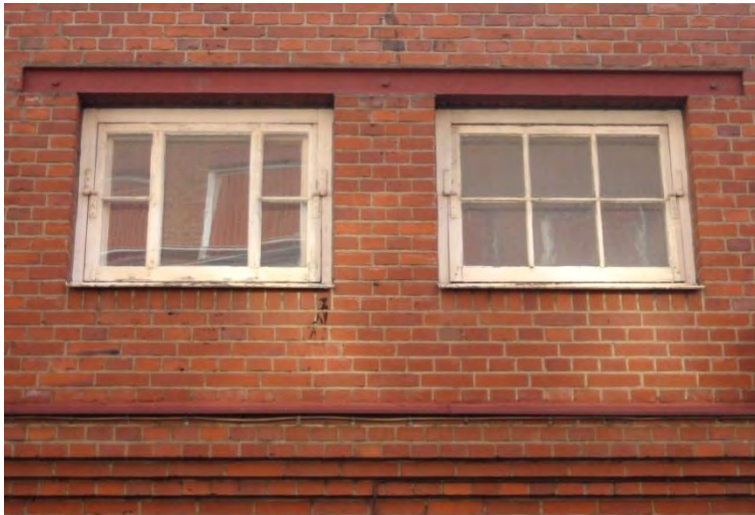
Fönsterbyten har gjorts löpande, redan tidigt i byggnadens historia.
