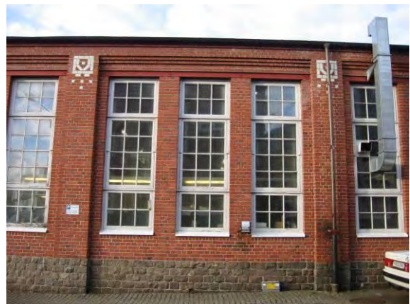
M-verkstden, detalj av fasad
