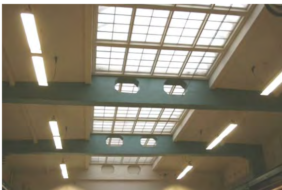
Takstol av betong samt liggande fönster under glasat sadeltak.
