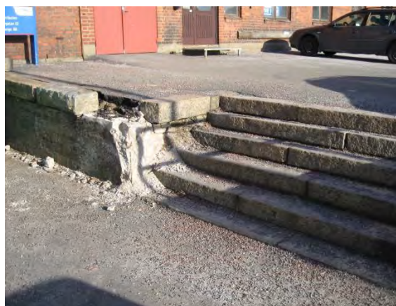
Stentrappa i anslutning till R-fabriken.
