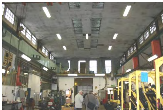
Södra delens verkstad. I samband med ombyggnaden till reparationsverkstad försågs hallen med ett nytt undertak.
