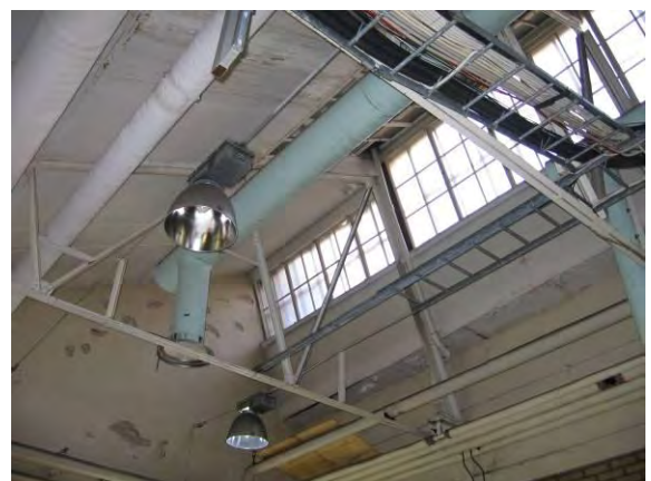
Ovan: Sågtandstakets spröjsade fönster är alla vända åt norr i syfte att åstadkomma ett skuggfritt ljus inne i lokalerna.
