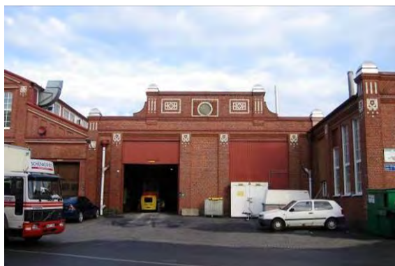
Mittpartiet – gavel mot söder.
