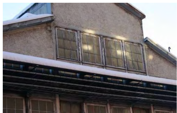
Spröjsade originalfönster i trä hängda i överkant.
