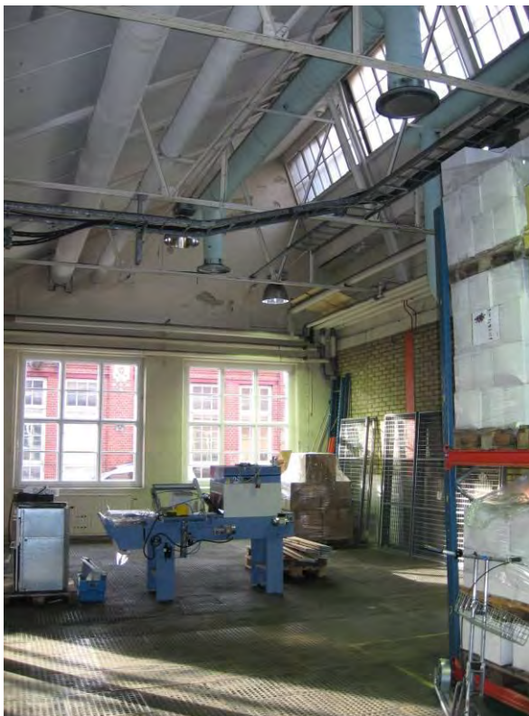
Sågtandstaket uppburet av smäckra takstolar i stål, I-balkar och stålpelare.
