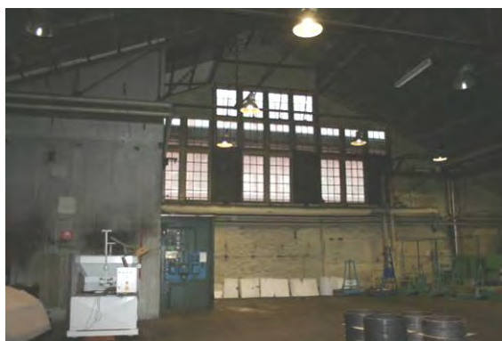
Spröjsade fönster mot norr.
