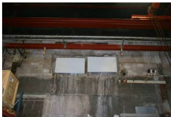
Del av gamla fasaden i skyddsgasanläggning från 1974.
