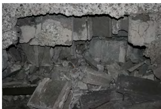
Detalj, betongsten och spritputs.
