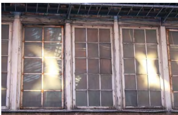
Fönster med båge i järn till vänster och spröjsade originalfönster till höger.
