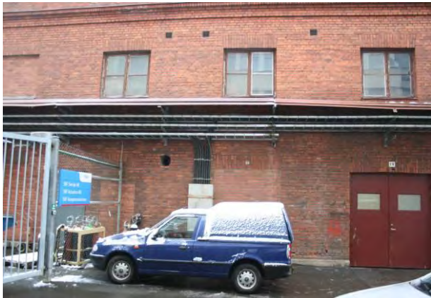
Detalj av norra fasaden med originalfönster bevarade. Igenmurade partier visar tydligt ursprungliga fönster- och dörrplaceringar. Dörren till höger i bild är utbytt.
