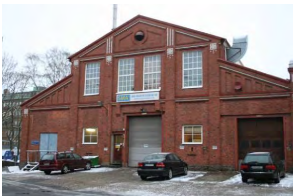
Västra delen – gavel mot söder.
