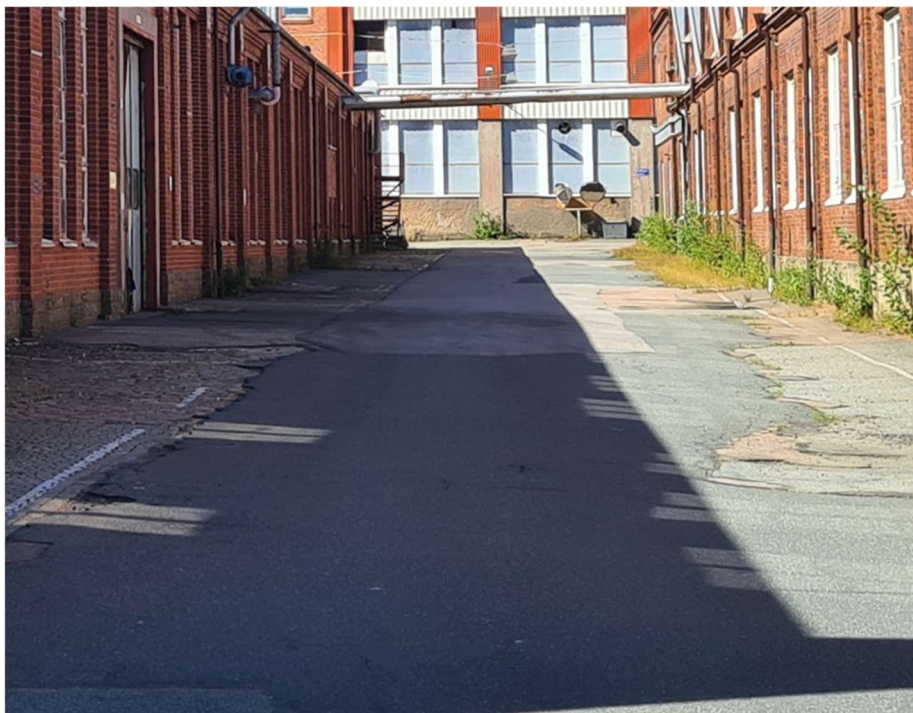
Figur 15. Arvid Palmgrens gata med gammal smågatsten och sprucken asfalt. (Platsbesök 2022-08-12)
