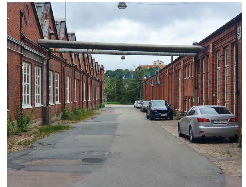
Tvärgatorna har en grön fond som utgörs av träd och sly utmed Säveån. Markbeläggningen utgörs av asfalt med inslag av gatsten. Foto: Johanna Lange.
