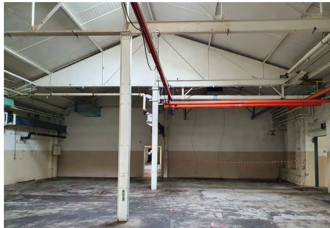
Den överbyggda gatan i mitten av M-verkstanen är en lätt konstruktion som består av pelare och takstol. Ytterväggarna, som tillhör intilliggande byggnader, till största del igensatta och övermålade. Bild: Johanna Lange
