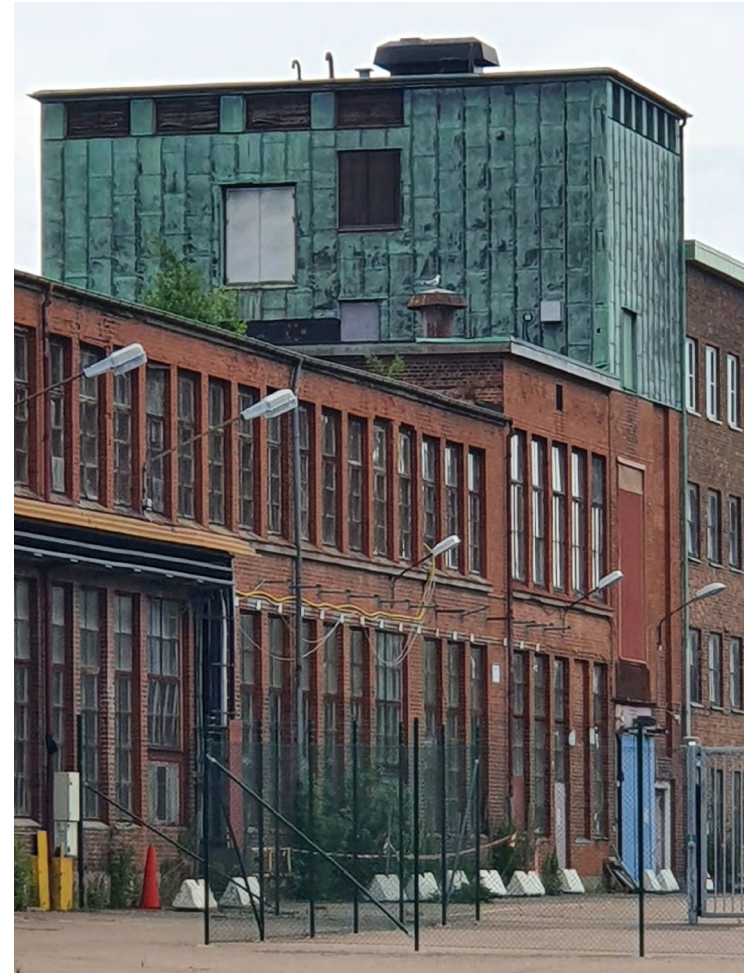
Sammanbyggda fabriksbyggnader med tegelfasader och överbyggnad med skivtäckt kopparplåt. Foto: Johanna Lange
