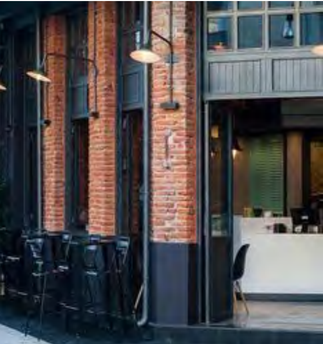
Exempel på belysning vid entré, här fasadmonterade armaturer vid restaurang.
