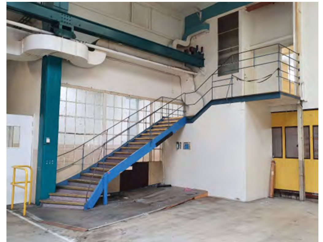
M-verkstaden med trappa i lätt konstruktion, smäckra räcken, glasade väggar, konstfärdigt utformade ventilationskanaler. Bild: Johanna Lange
