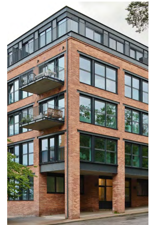
Ombyggnad av kontorsbyggnad till bostadshus i Nacka. Arkitekt: Hermansson, Hiller, Lundberg arkitekter. Bild: Mikael Olsson
