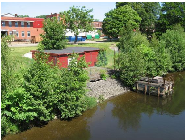
Mellan fabriker och å finns ett parkliknande parti. Foto WSP Industriområdena på båda sidor om ån är inhägnade. Framför stängslen finns erosionsskydd, till stor del i form av makadamslänter. Foto Norconsult
