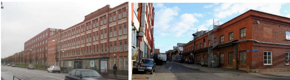
Den långa fasaden mot Artillerigatan och den inre parallella Rullagergatan.
