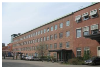
V-fabriken (Härden) till vänster samt största delen av S-fabriken till höger kommer att ersättas av nya byggnader.
