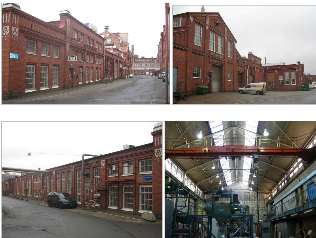
Fasader mot norr, söder och öster samt verkstadshall.
