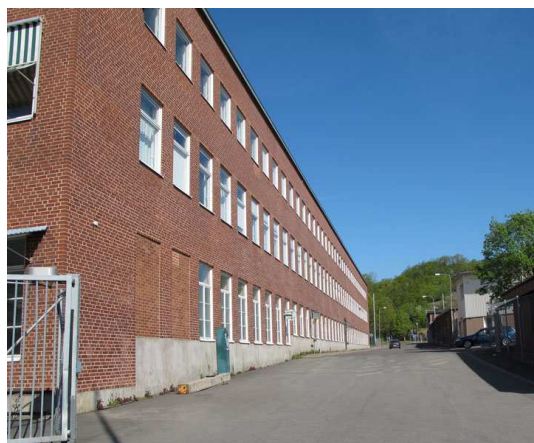
Fasad mot Ryttmästaregatan.
