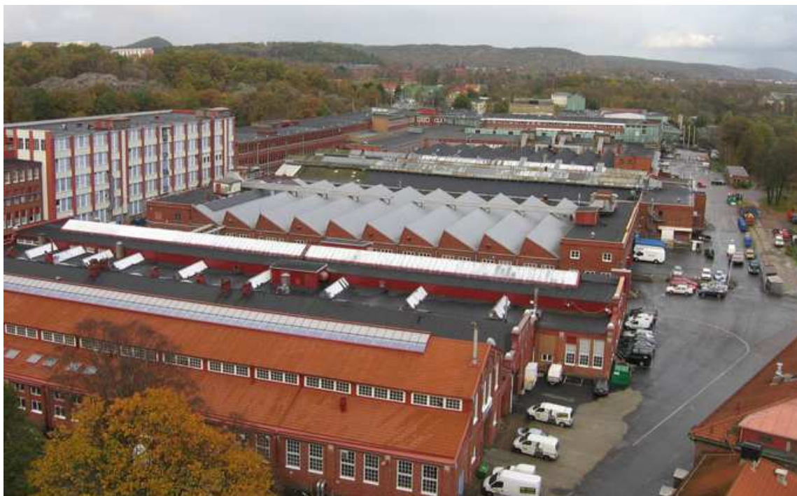
Kvarteret sett från SKF:s huvudkontor. I förgrunden M-verkstaden med två basilikaformade hallar, därbakom R-fabriken med sågtandstak. Till vänster i bilden sticker K-fabriken upp i "muren" mot Artillerigatan. Till höger lastgårdar mot åravin.
