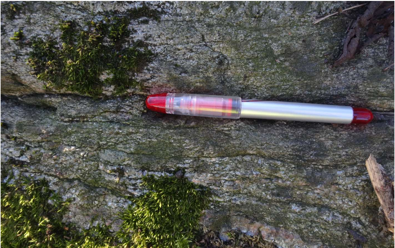
Bild 3 där man ser bergets struktur med relativt stora kristaller lokalt med inslag av pegmatitgångar. Ytan är relativt, rå vilket minskar risken för att berget skall glida isär. Inga betydande sprickfyllnader kunde konstateras.
