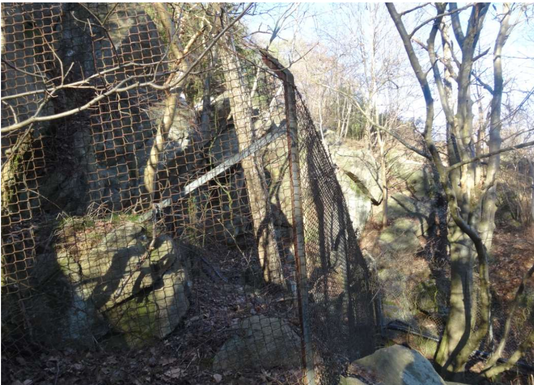
Bild 7 på staketet som inringar området med större lösa block i sprickzonen. Risknivån bedöms vara måttlig.
