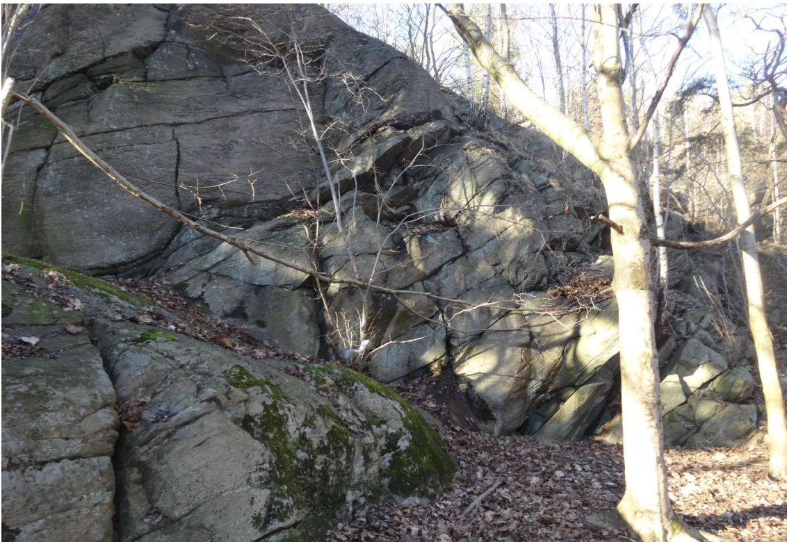
Bild 9 på området där bergets foliation har skapat öppna sprickor som lokalt kräver någon form av åtgärd. Områden har markerats på planskissen. Åtgärden bestäms efter skrotning har utförts. Risknivån bedöms vara måttlig.
