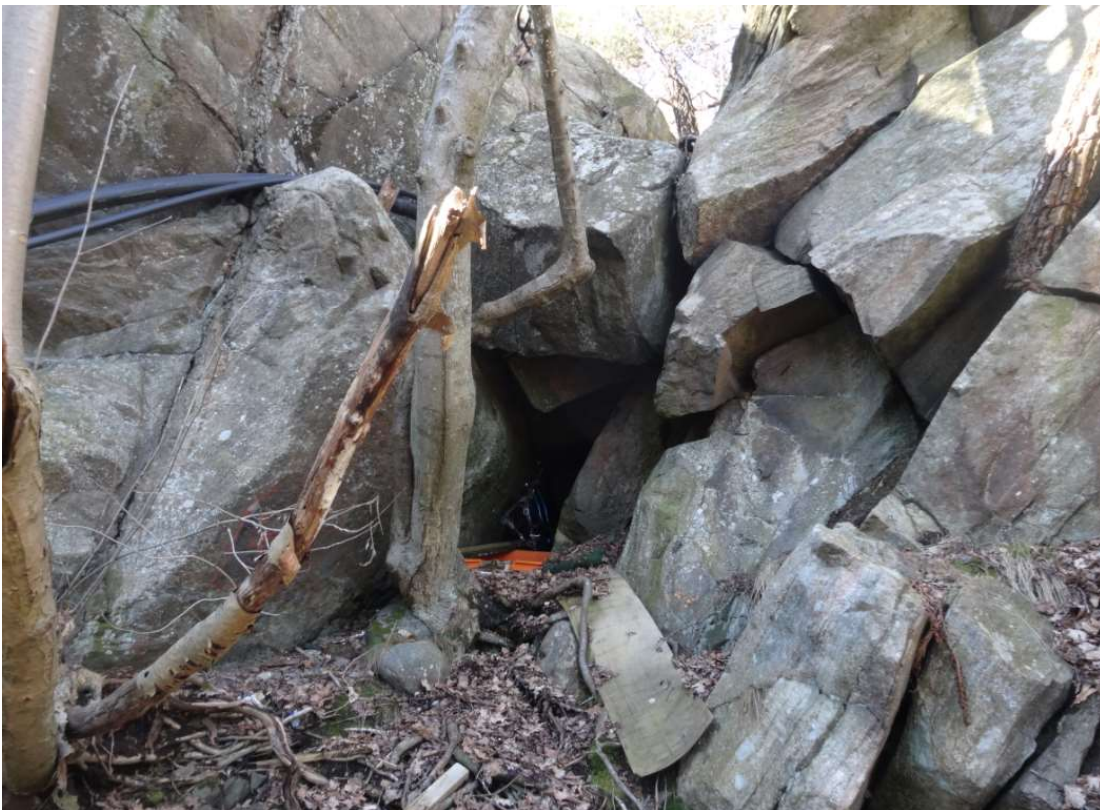
Bild 6 på det speciella området där stora lösa block förekommer med stor risk för rörelse. Terrängen är speciell då det nästen utgör en grotta med lösa mycket stora block som tak. Blocken bedöms dock vara delvis fastkilade, vilket innebär att dom är svåra att flytta. Förslagsvis görs en översyn i senare skede men, framförallt skall staketets kvalitet kontrolleras som syns på nästa bild.
