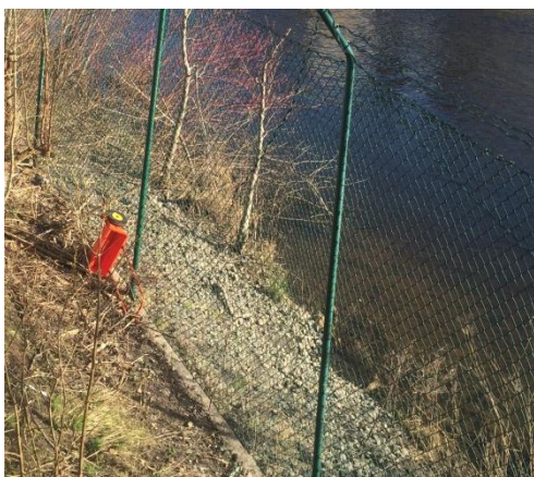
Figur 9 Befintligt erosionsskydd längs Sävåns norra strandkant vid Hornsgatan/Kullagergatan
