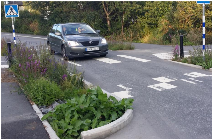
Figur 7 Exempelbild på biofilter (foto: Sweco)
