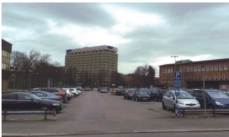
Området sett från Byfogdegatan i söder.
