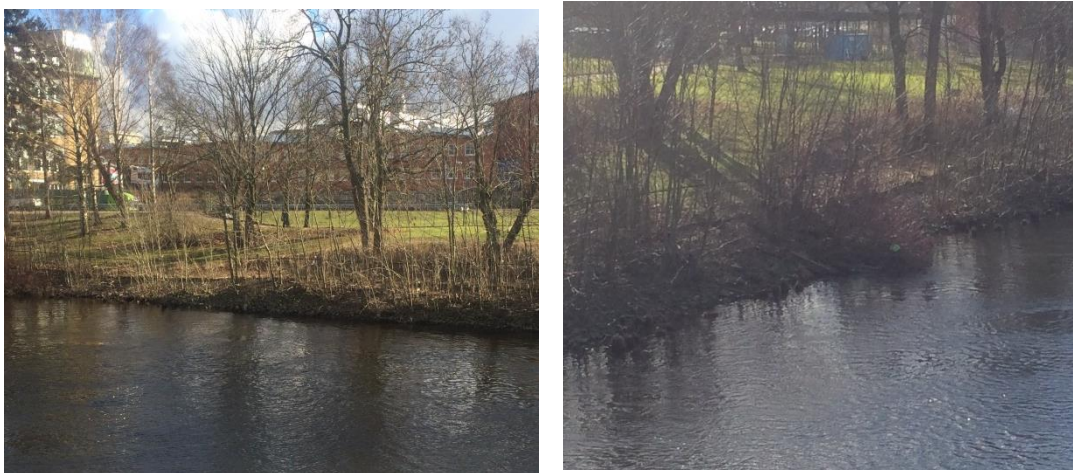
Figur 8 Befintligt erosionsskydd längs Sävåns södra sida
