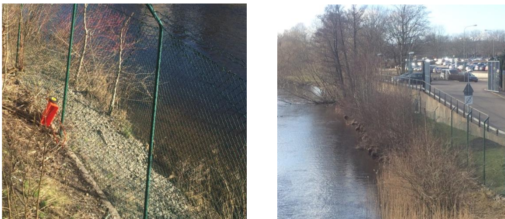
Figur 9 Befintligt erosionsskydd längs Sävåns norra strandkant vid Hornsgatan/Kullagergatan
