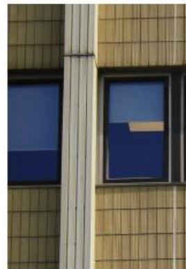
Originalpilaster klädd med eloxerad aluminiumplåt. Pigmenten har blekts med åren.
