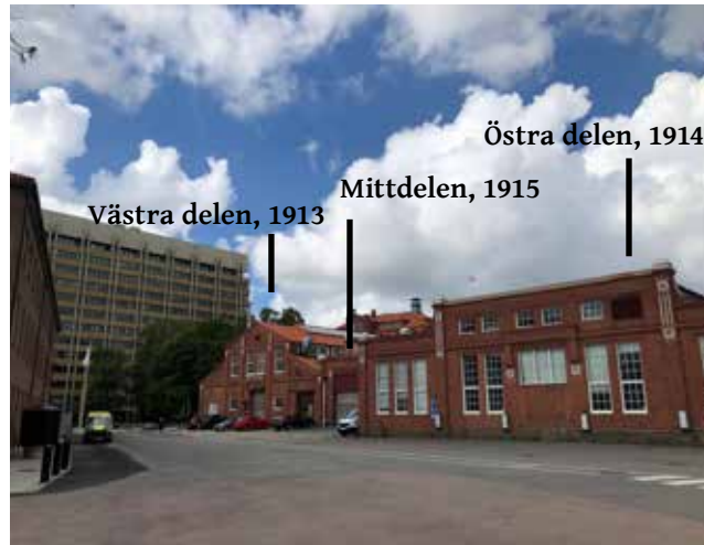
M-byggnadens tre sammanbyggda gavlar mot söder.
