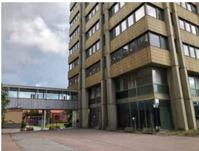
Gångbro i glas och grå aluminium mellan norra kortsidans andra våningsplan och HK2.
