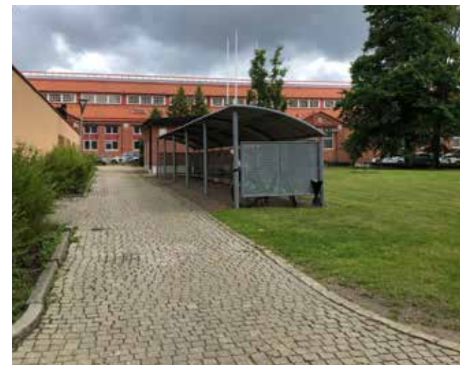
Gångväg med smågatsten vid parkytans norra del. Cykelställ och elcentral senare tillkomna.
