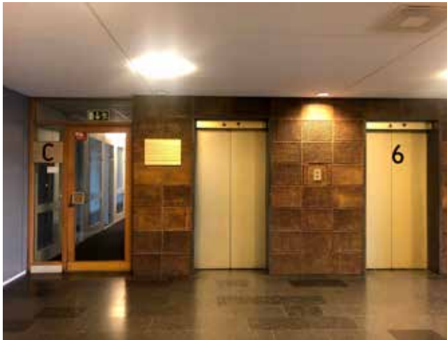
Samtliga hisshallar har väggkeramik i varierande mönster. De flesta skiljedörrar i trä är original.
