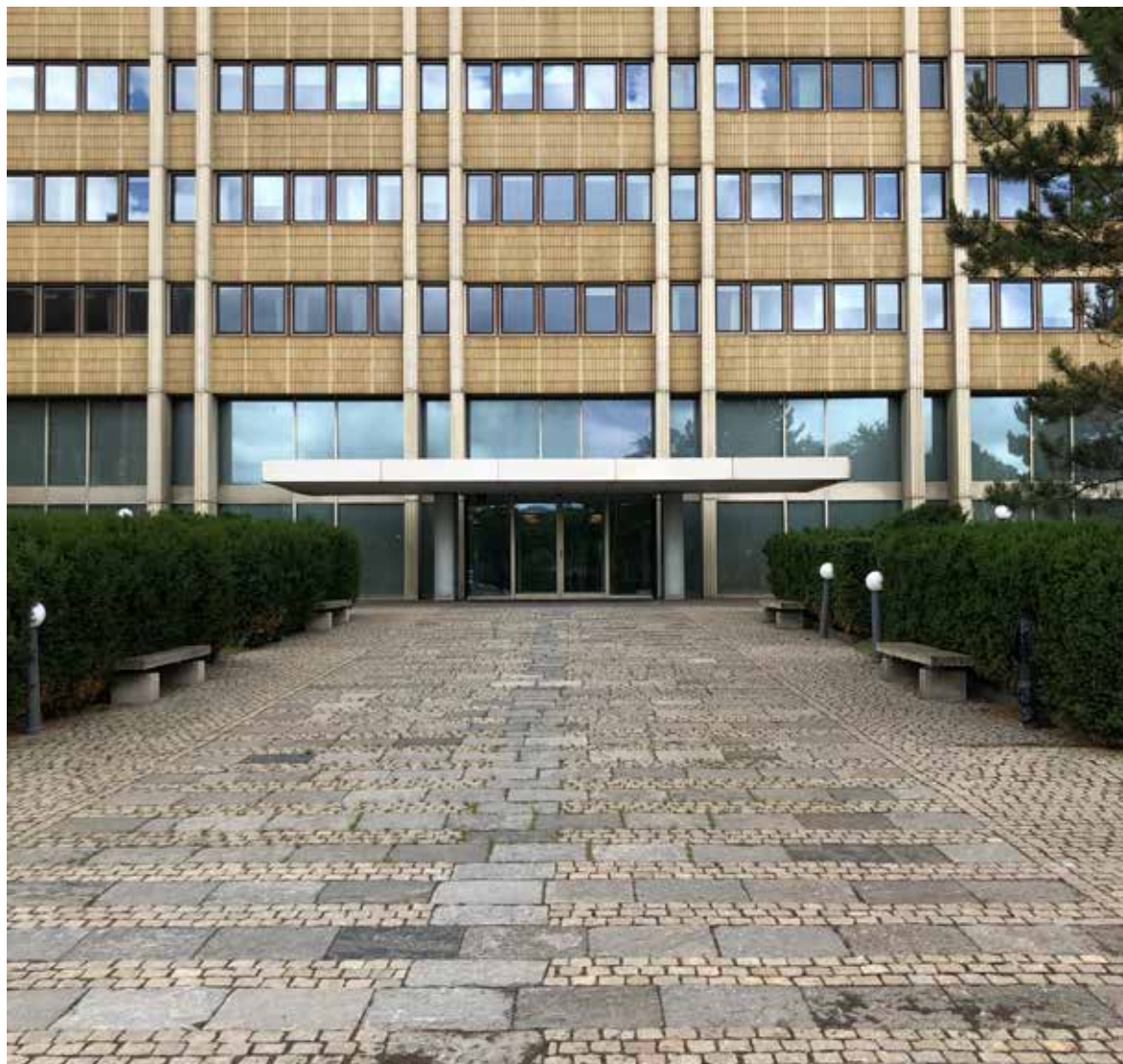
HK3 byggnadens entréplan har panoramafönster. Rektangulärformade pelare klädda i glaspaneler håller upp utskjutande entrétak klädd i eloxerad aluminium.
