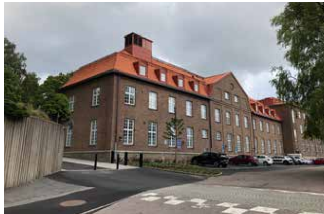
Lab 1, fasad mot Kullagergatan. Inredd takvåning under ett brutet tegeltäckt tak. Fasadens symmetri bryts upp av mittparti med bred frontespis.
