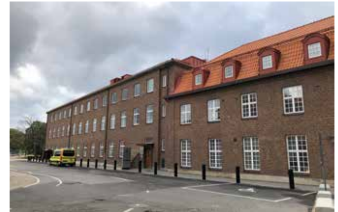
Lab 1 och 2, fasader mot Sven Qingquists gata. Trots tydlig arkitektonisk uppdelning, ansluter byggnaderna harmoniskt till varandra.
