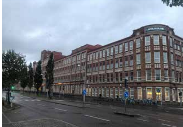
A-fabrikens tegelfasad mot Artillerigatan. Långa horisontella linjer bryts upp av de olika byggnadskropparna samt mittparti med klocktorn.
