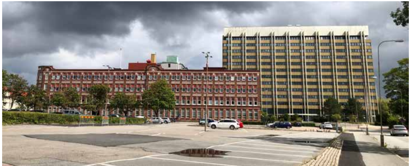
A-fabrikens tegelfasad mot Hornsgatan. Trots dess fyra våningar höga fasad ligger tyngdpunkten horisontellt, i och med de långa symmetriska fönsterraderna.
