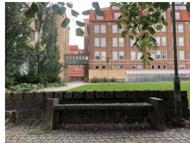
Platsbildning med fristående murparti framför HK3:s östra entré. Sittbänk i betong och trä sits framför.
