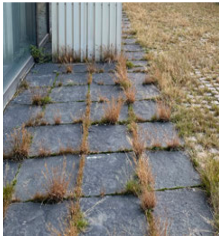
Fjäråsgnejs, binder samman in och utsida av byggnaden
