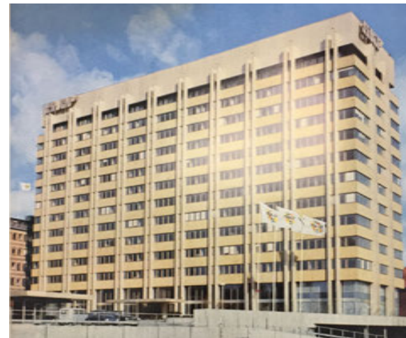
Originalplåtens ljusgula ton
