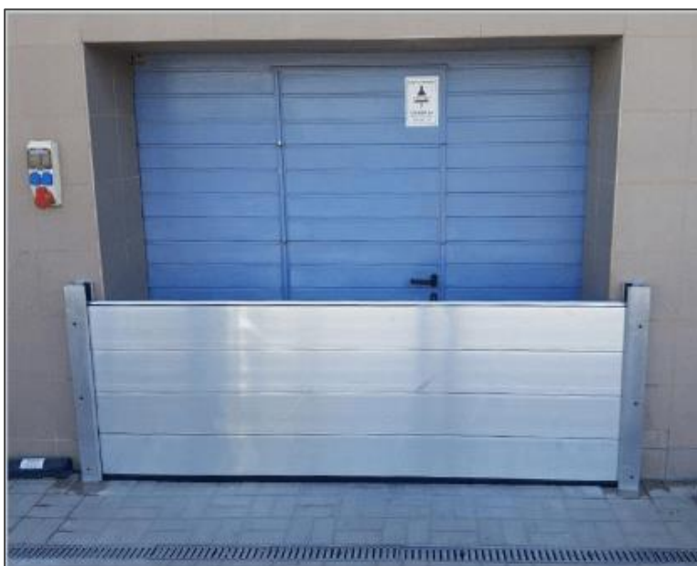
Figur 3. Exempelbild översvämningsskydd för byggnader. Källa: (Hydratec, 2021)
