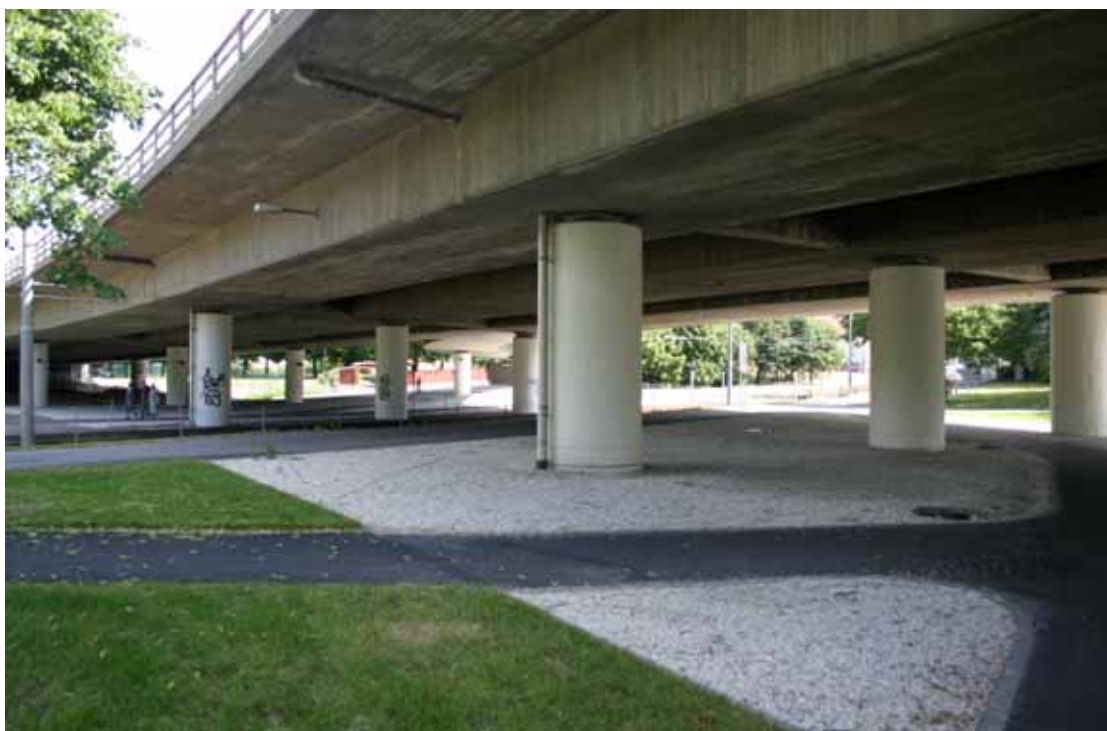
Befintliga trafikviadukten kommer att rivas vid genomförandet av etapp 2.
