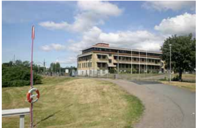
Tegelbyggnaden vid Johan Gertssons gata kommer att rivas.
