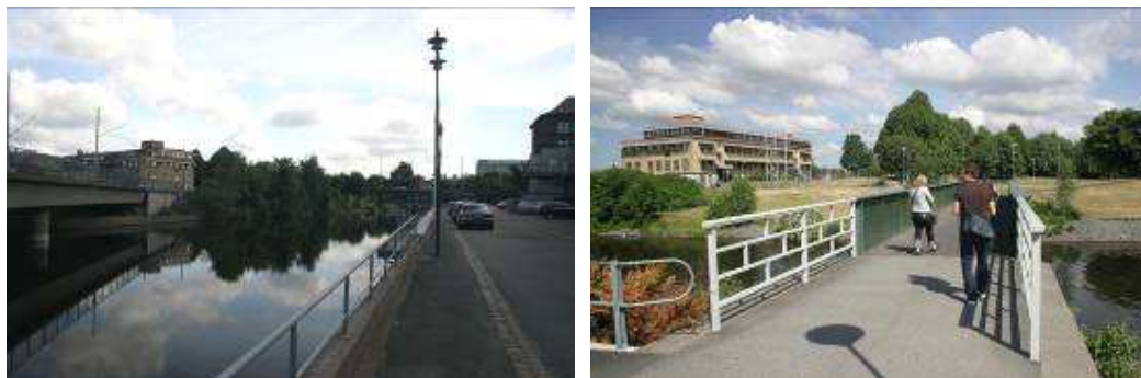
Vänster: Foto söderifrån kajen vid Gamlestadens fabriker över norra stranden, med befintlig spårvägsbro till vänster i bild och vegetation i anslutning till ån. Höger: Foto söderifrån över befintlig gångbro till norra stranden. Här har befintlig stödmur övergått till kaj.
