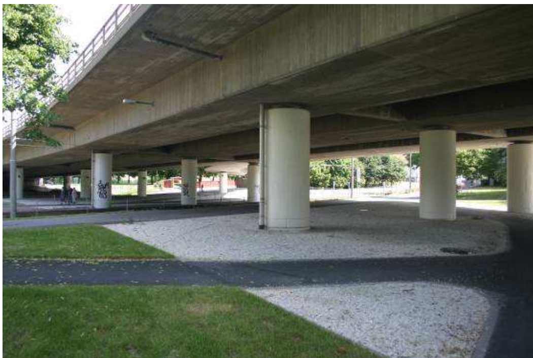
Befintlig trafikviadukt kommer att rivas.
